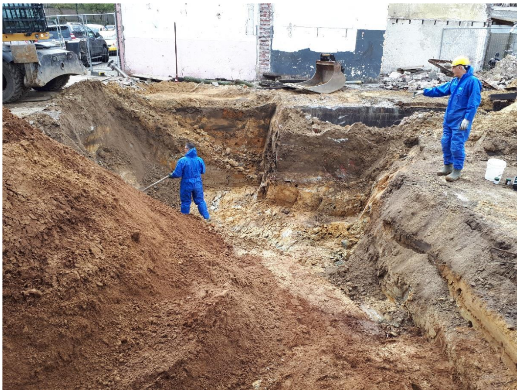
Afbeelding 1.2: De sanering van de minerale olietank met rechtsachter de smeerput (Foto: Synthebra B.V.)
