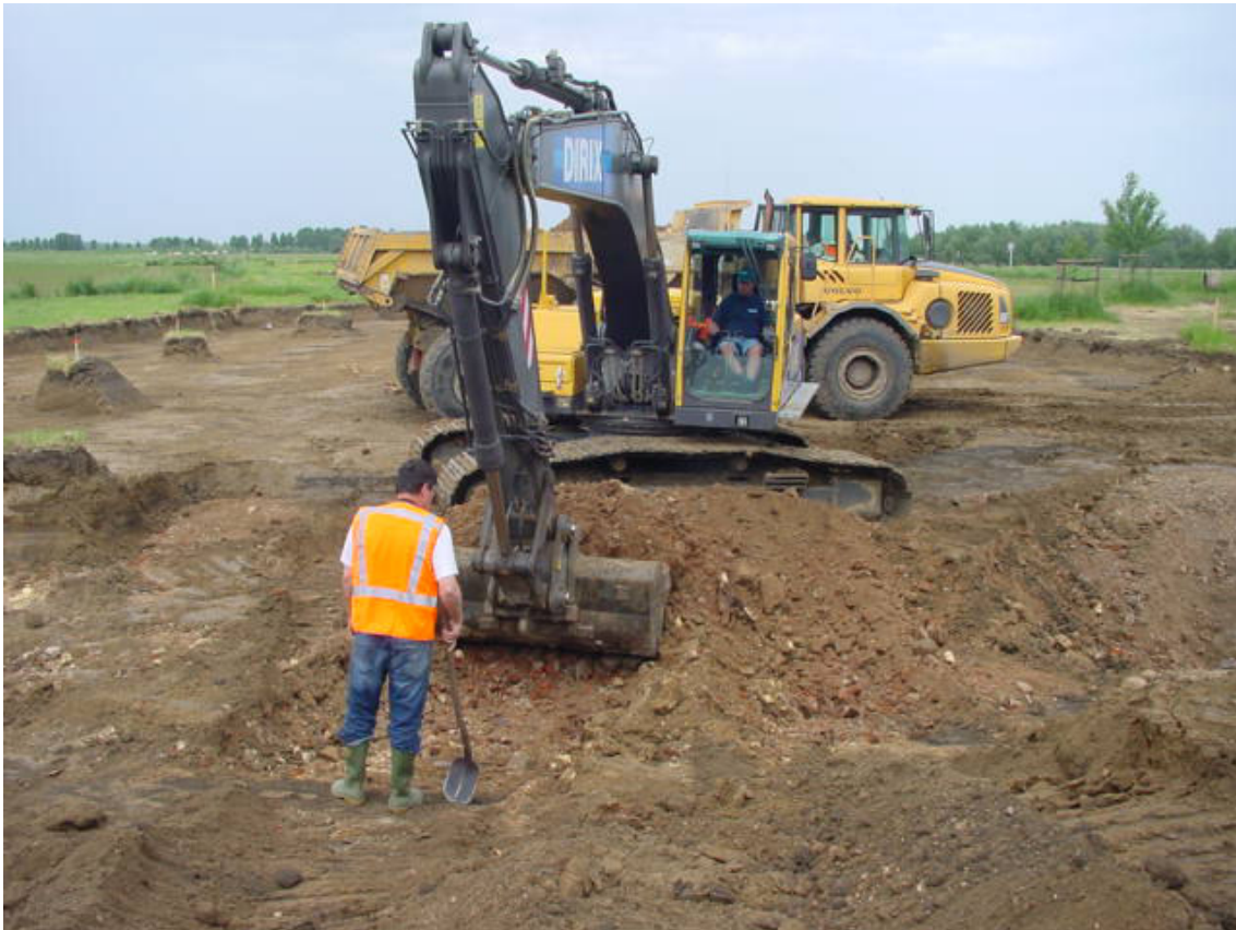
Figuur 2. Het verwijderen van het puin uit de voormalige bedding van de Vlootbeek.
