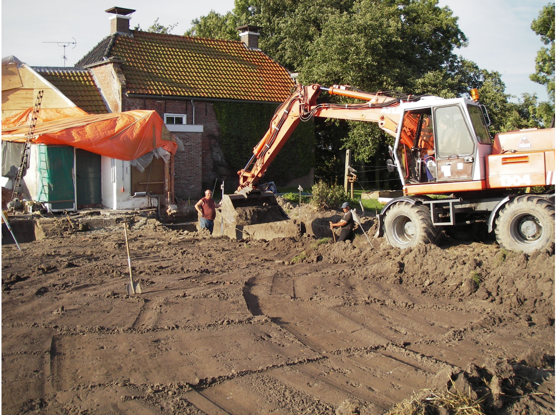
Figuur 6. Eenrum, Oosterweg 7. Foto van het plangebied. De foto is gemaakt richting het zuiden. De foto toont de werkzaamheden in de zuidelijke locatie, waar de schuur van de boerderij is vervangen.
