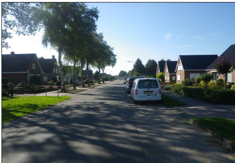
Afbeelding 10. De Brugstraat in Klazienaveen, gezien naar het zuiden
