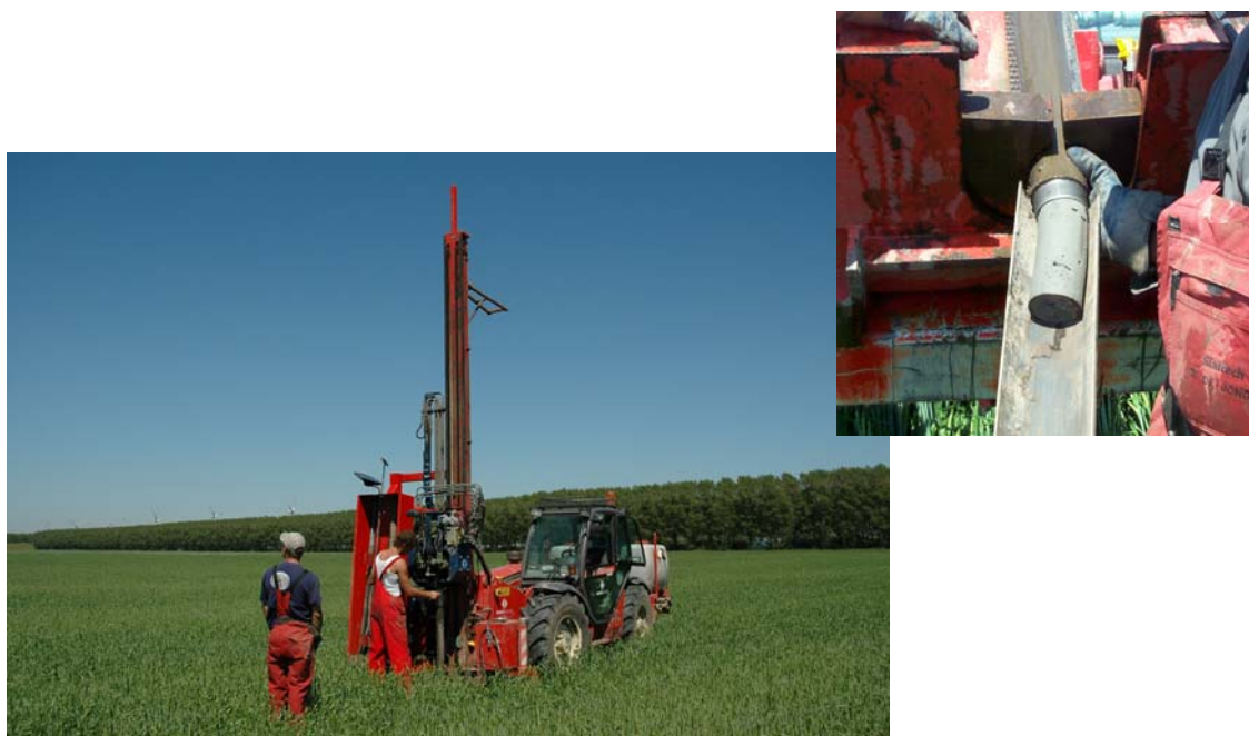
Figuur 4.1 Het booronderzoek vond plaats door middel van een Aqualock-boor. Met dit apparaat kunnen onverstoorde monsters worden gestoken met een diameter van 7 cm (zie inzet).
