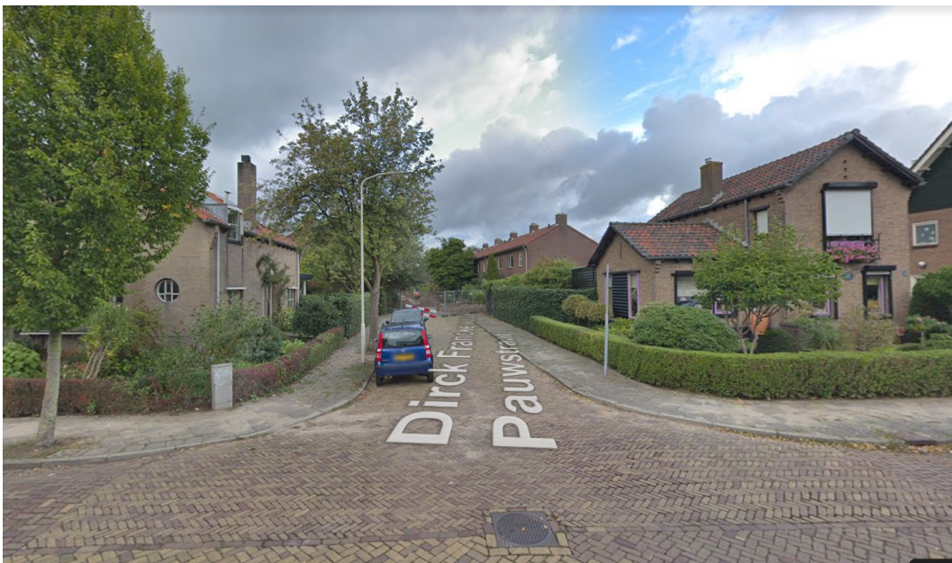
Figuur 6: De Dirck Franckenszoon Pauwstraat gezien vanaf de Marinus Spronklaan in noordelijke richting (Google Maps Street View, september 2018).
