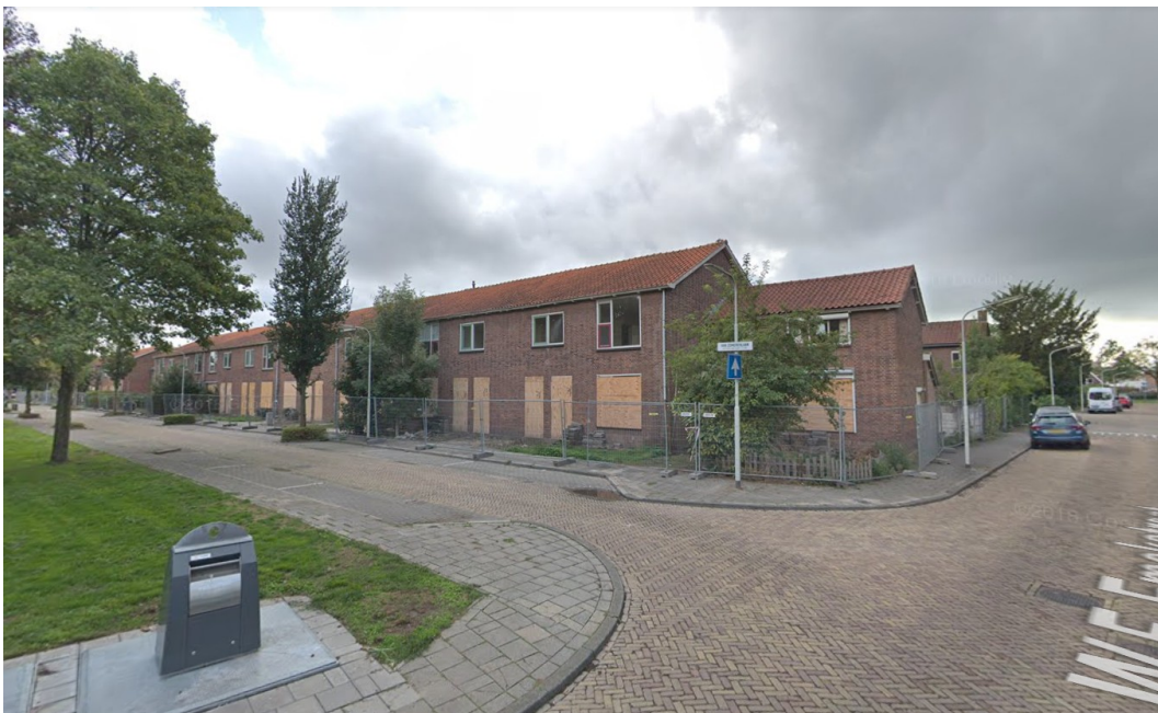
Figuur 5: Het plangebied gezien vanaf de driesprong met de W.F. Emckstraat en Van Zomerendaal in zuidwestelijke richting (Google Maps Street View, september 2018).
