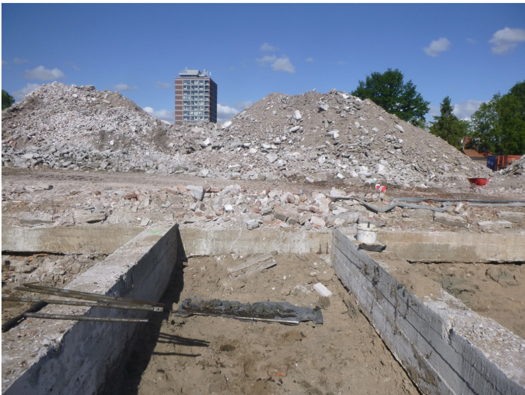
Figuur 40: Foto gemaakt tijdens veldwerk, funderingen bij boorpunt 8.
