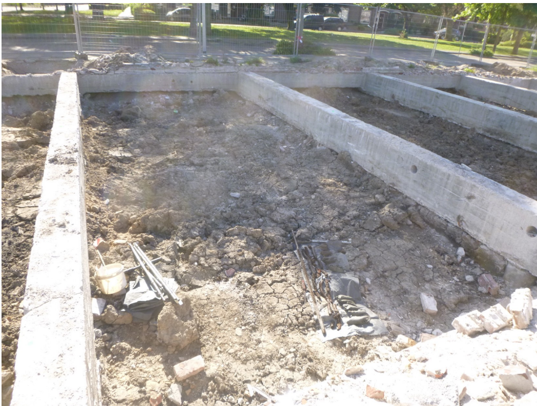
Figuur 39: Foto gemaakt tijdens veldwerk, funderingen bij boorpunt 2.
