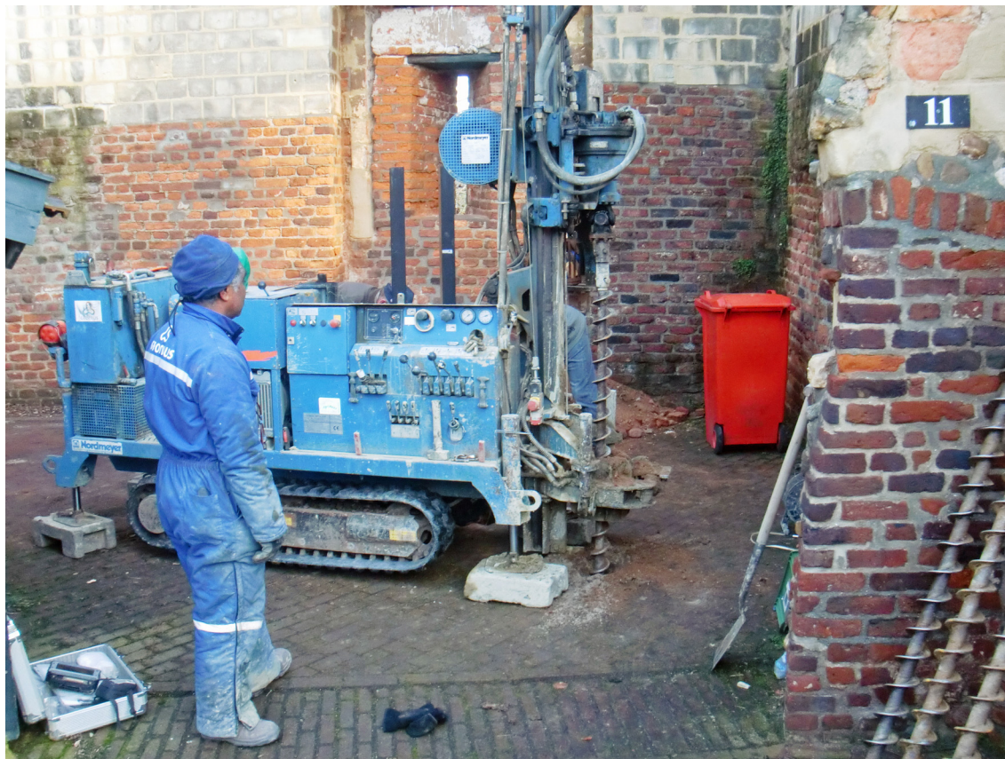
Figuur 5. De avegaarboor in werking.
