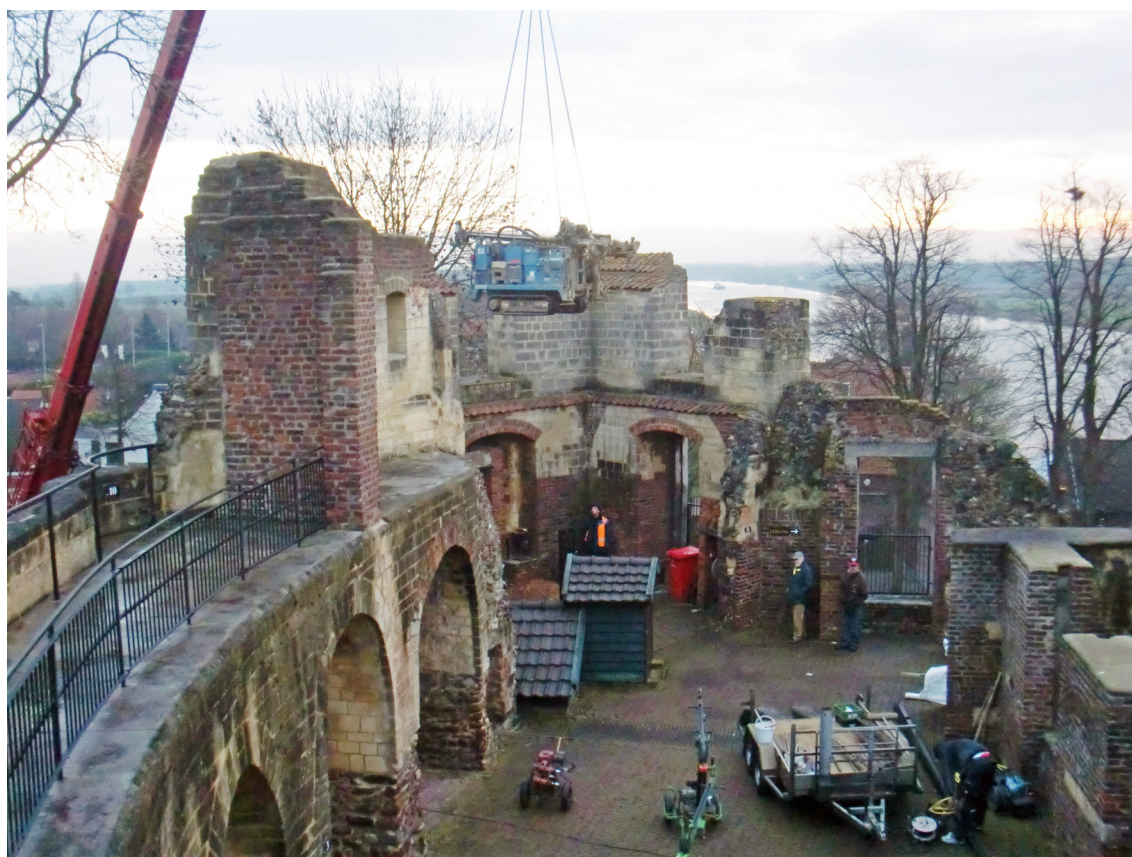
Figuur 4. De boorstelling wordt op het binnenterrein gehesen.
