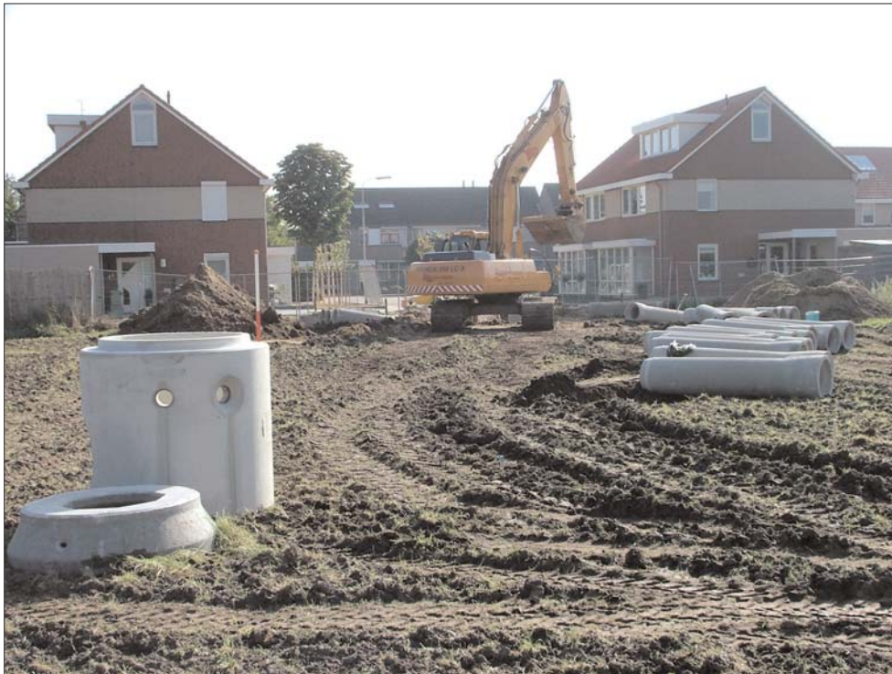
Figuur 2. Graafwerkzaamheden t.b.v. de rioolsleuf.
