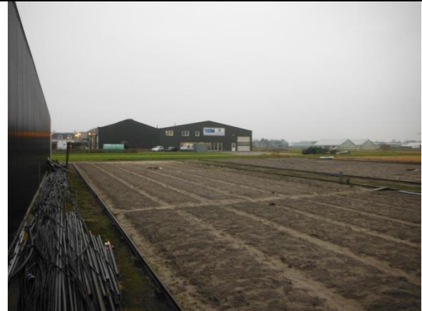
Vanuit oostelijke richting nabij boring 3
