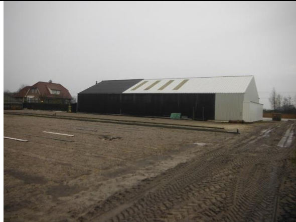
Vanuit zuidelijke richting nabij boring 1
