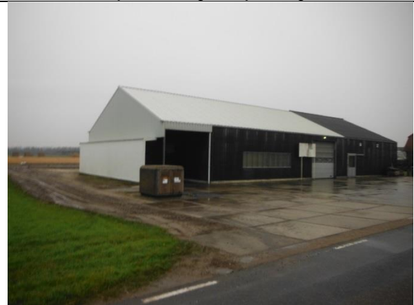
Vanuit zuidelijke richting nabij boring 8
