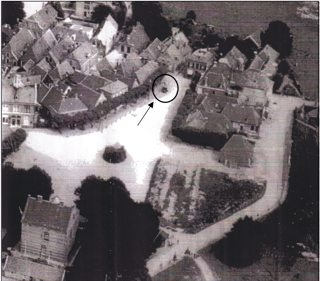
Figuur 3.4 Een luchtfoto van een deel van deelgebied 3 en omgeving uit 1925. Linksonder in de foto is nog het oude kantongerechtsgebouw met één van de bijgebouwen te zien. Eveneens zijn het stadhuis en andere gebouwen (mogelijk boerderijen en schuren) en de oude houten brug rechtsboven in de foto waarneembaar. De weg vanaf de brug loopt hier nog tussen het stadhuis en de Vecht door. De waterput die in Bijlage 2 op de eerste kadastrale kaart uit 1830 is weergegeven, is mogelijk op de foto waarneembaar. Deze locatie is omcirkeld en met zwarte pijl aangegeven. Bron: Archief Gemeente Ommen.
