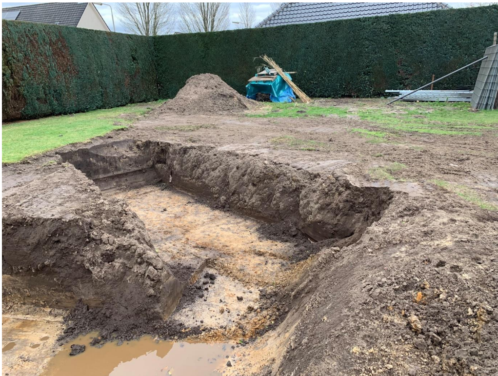
Figuur 12. Zicht op de ontgraving, foto genomen vanuit het zuidwesten.
