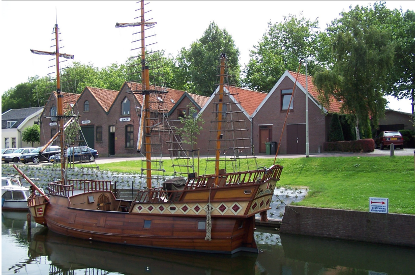
De huidige situatie; de stoomzuivelfabriek staat links op de foto (drie enigszins gelijke gevels)
