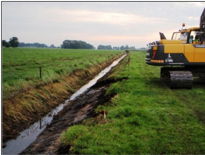
Afbeelding 3. Foto van het begin van de werkzaamheden in deelgebied 1. De foto is in zuidelijke richting gemaakt
