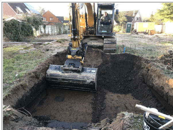
Figuur 7. Apeldoorn, Maria Stuartstraat (west van huisnummer 75): Foto van de aanleg van proefsleuf 2. De foto is genomen richting het zuiden.
