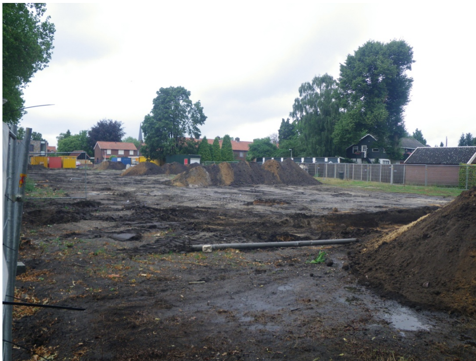
Fig. 2: Het plangebied na aanleg van de proefsleuven.
