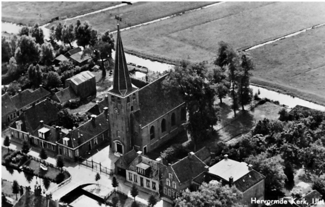
Figuur 3. IJlst, Eegracht 43. Ansichtkaart van IJlst met daarop de Sint Mauritiuskerk en de pastorie (het gebouw rechtsonder met de vier schoorstenen) die tot halverwege de twintigste eeuw op de locatie stond van het huidige pand op de Eegracht 43.
