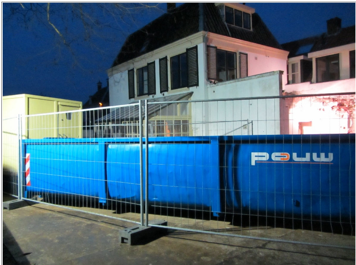
Figuur 1. Foto van de plangebied met de benodigde veiligheidsmaatregelen. Vanwege de verontreinigde grond is het plangebied afgezet met hekken. De grond wordt in containers afgevoerd en medewerkers zijn verplicht het terrein via een decontaminatie-unit (links in beeld) te betreden en te verlaten.
