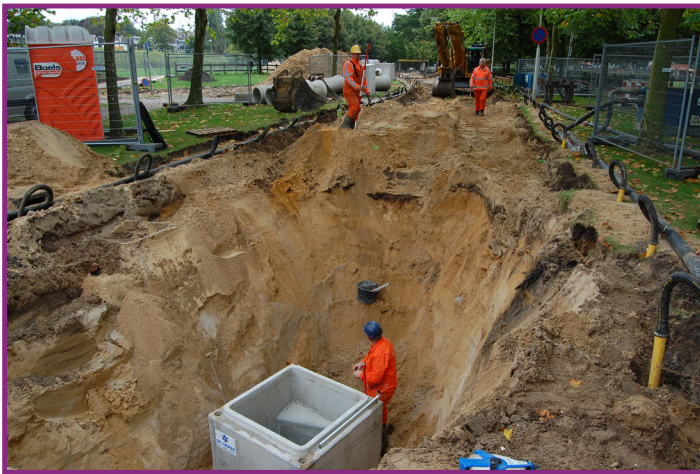
Afbeelding 12. Plaatsing van het riool op de maximale te ontgraven diepte in het wegtracé van de Ruitenberglaan, geflankeerd door bronbemaling (gemeente Arnhem, richting oost).
