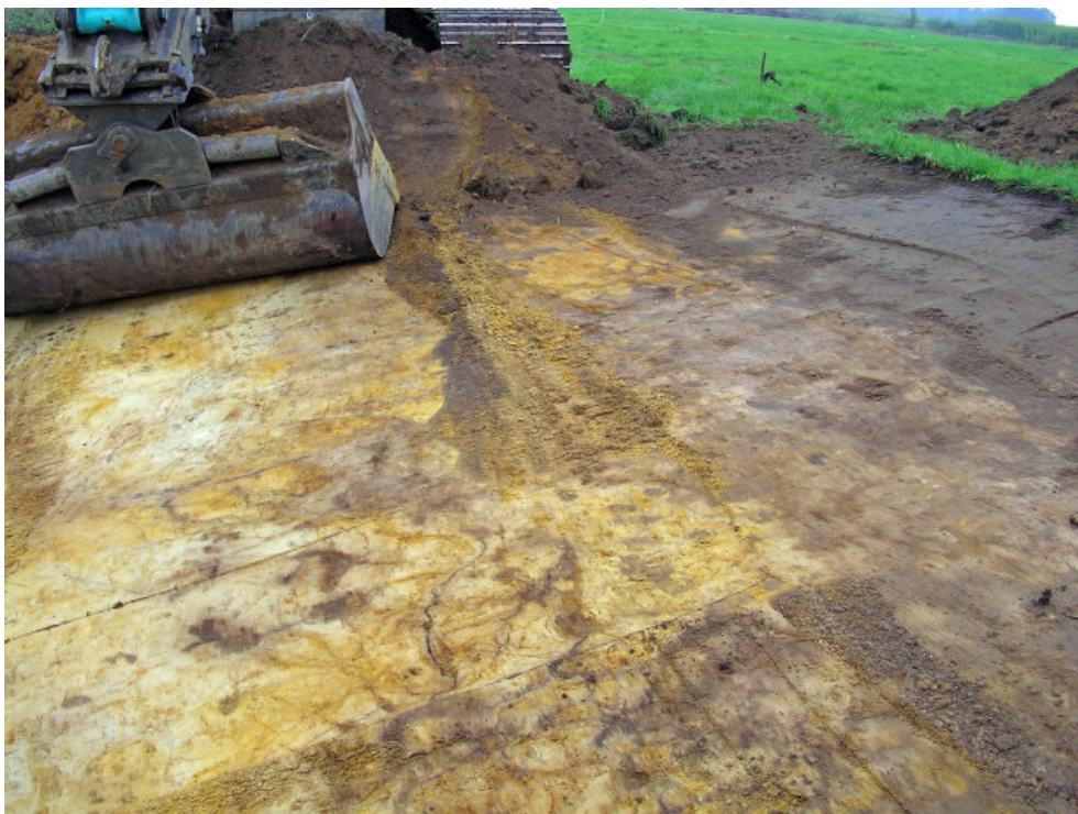
Figuur 7. De ontgraving ter hoogte van de boringen 1 en 2 (zie kaartbijlage 1 voor de locatie)
