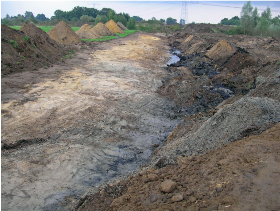
Figuur 6. Overzicht richting het zuid-zuidoosten van het aangelegde flauwe talud langs begeleidingszone 1 (zie kaartbijlage 1 voor de locatie). Zichtbaar zijn het plaggendek, het dekzandpakket en de oeverafzettingen (stootoevertingen) van de oude beekloop.
