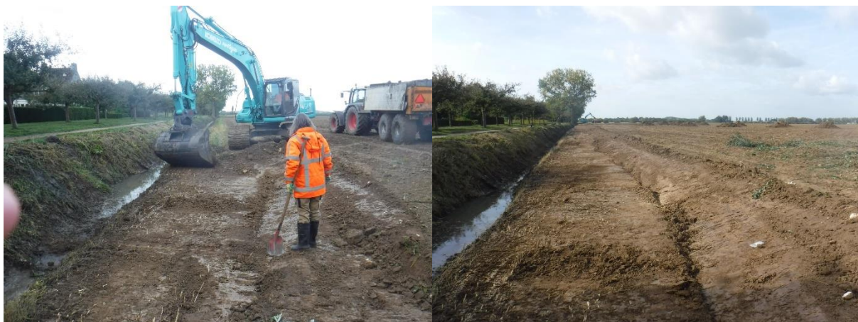
Afbeelding 3 Start (links) en einde (rechts) van de graafwerkzaamheden/aanleg werkput 1
