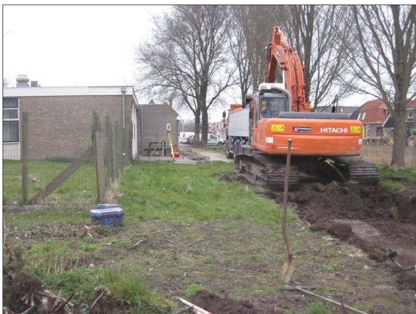
Afbeelding 2. Foto van de locatie van werkput 1a, aan het begin van de werkzaamheden
