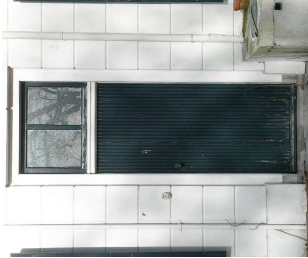
Afbeelding 36. Detail van de voordeur van het woonhuisgedeelte. Rechts een regenwatertank.
