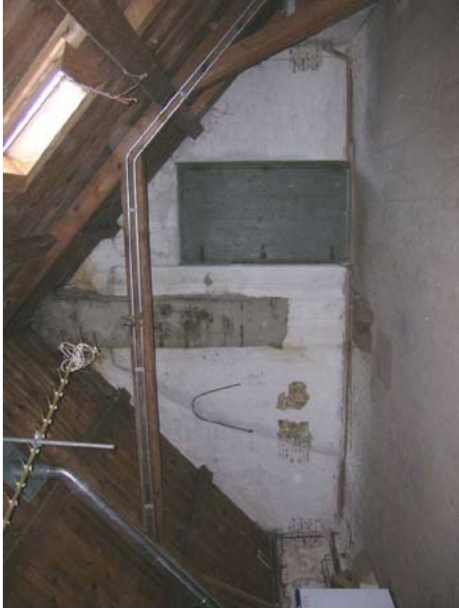
Afbeelding 134. Zicht op de brandmuur met het oude en huidige rookkanaal in het voorhuis.
