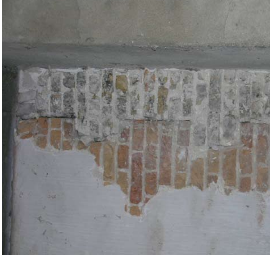
Afbeelding 8. Bouwspoor 10. Links het metselwerk van de bouwmuur (18 x 8,5 x 4 cm met een tienlagenmaat van 54 cm) en rechts de inkassing van het rookkanaal (steendikte 4 cm met een tienlagenmaat van 48 cm). Beide muurdelen bezitten een stroomlaag onder de strijkbalk. De inkassing hoort bij de verkleining ten behoeve van het huidige rookkanaal.
