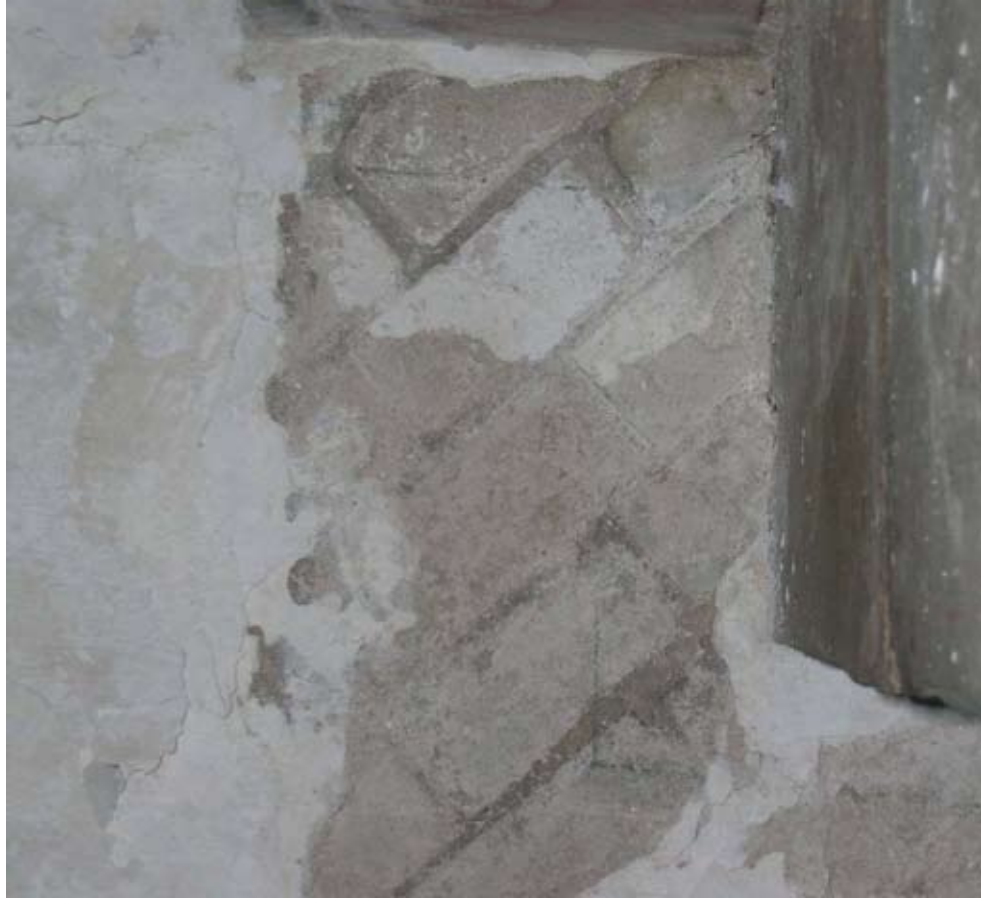
Afbeelding 122. Detail van de vorige afbeelding met de halfsteens diagonaal gemetselde kelderklamp.
