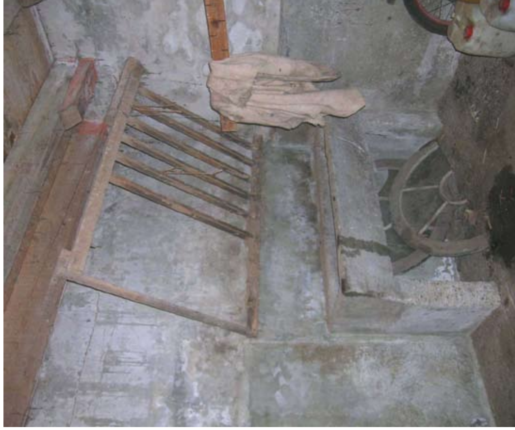
Afbeelding 107. Zicht in de linker paardenbox met de houten ruif en betonnen voederbak.
