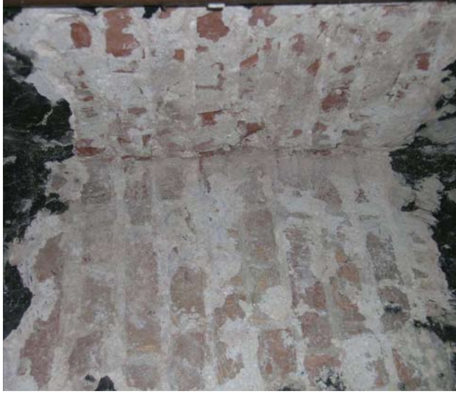
Afbeelding 6. Bouwspoor 8. Links het metselwerk van de bouwmuur (18 x 8,5 x 4 cm met een tienlagenmaat van 54 cm) en rechts de achtergevel (22 x 10,5 x 4,5 cm met een tienlagenmaat van 54 cm), die hier koud tegenaan staat.
