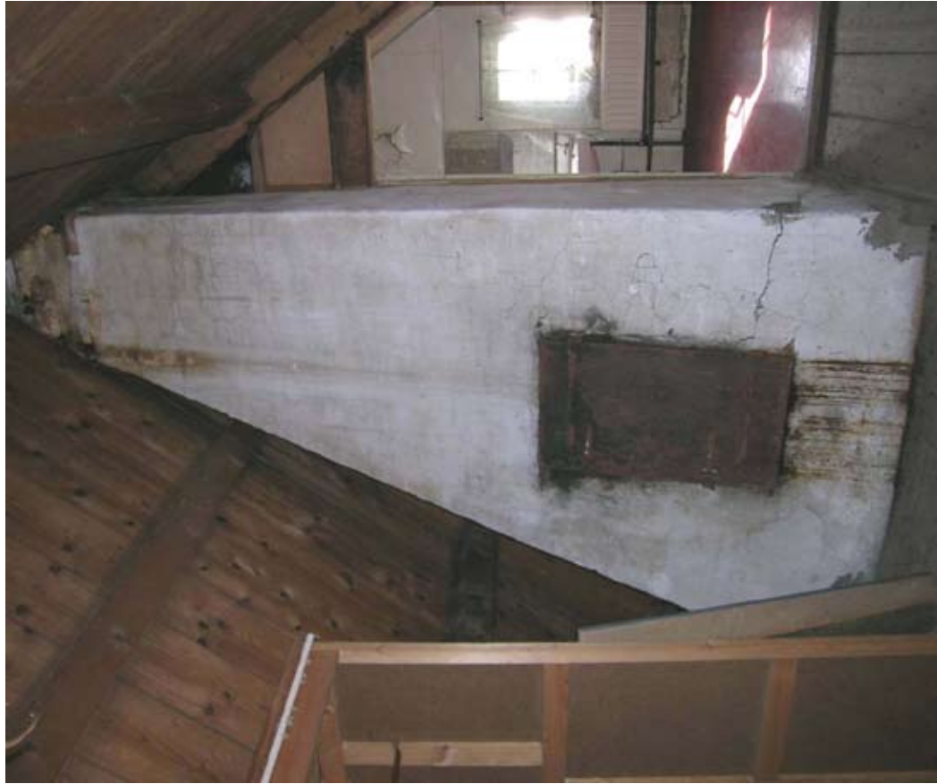
Afbeelding 146. Zicht op het rookkanaal op de zolder van het achterhuis
