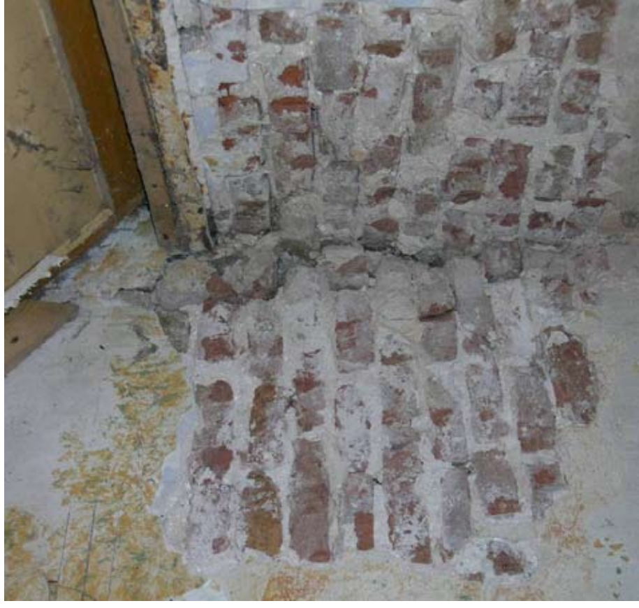
Afbeelding 9. Bouwspoor 13. Links het metselwerk van de zijgevel van het voorhuis en rechts de voorgevel (22,5/23 x 11 x 4 cm met een tienlagenmaat van 50 cm), die op dit niveau in verband staan.
