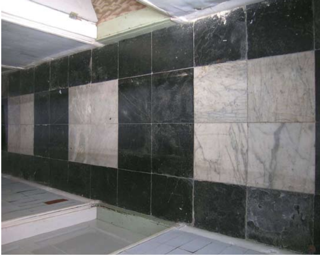
Afbeelding 70. Detail van de hardstenen en witmarmere plavuizen van de vloer in de middengang. De plavuizen zijn hergebruikt.
