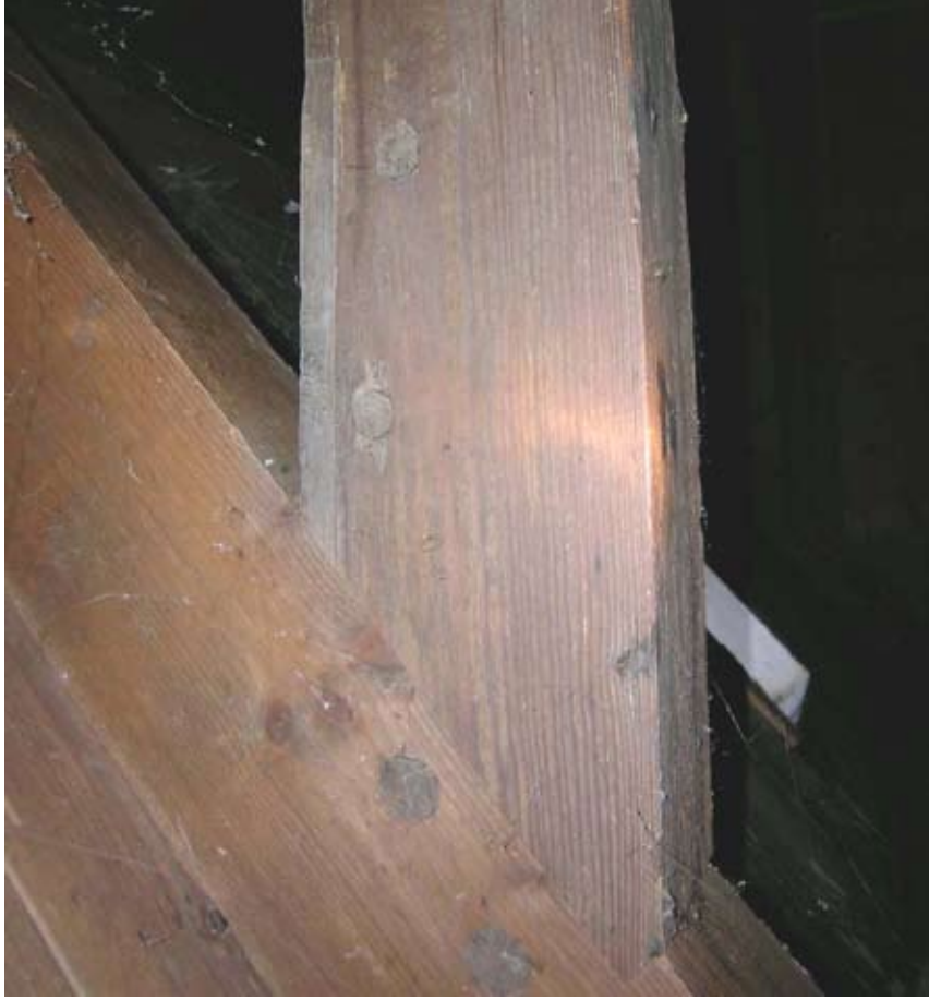
Afbeelding 138. Detail van een hanebalk in de kap van het voorhuis met uitstukking en twee toognagels van een oudere constructie.
