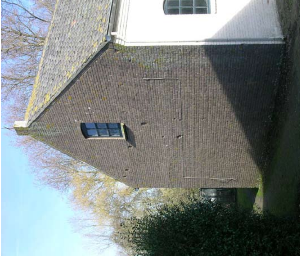
Afbeelding 44. De zijgevel van de paardenstal. Het metselwerk bestaat uit bakstenen van 21,5 x 10,5 x 5,5 cm met een tienlagenmaat van 63 cm (bouwspoor 6).
