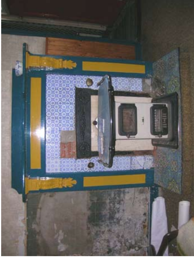
Afbeelding 114. Detail van de laat 19 de -eeuwse haard in de keuken. In de haardopening is een oudere –vroeg 19 de -eeuwse – gietijzeren haard in empire stijl geplaatst.
