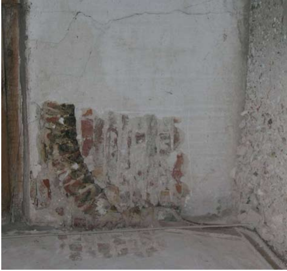
Afbeelding 12. Bouwspoor 16 met de segmentboogvormige doorgang in de bouwmuur tussen voor- en achterhuis. De boogvulling bestaat uit bakstenen met een steendikte van 4 cm en een 10-lagenmaat van 48 cm.
