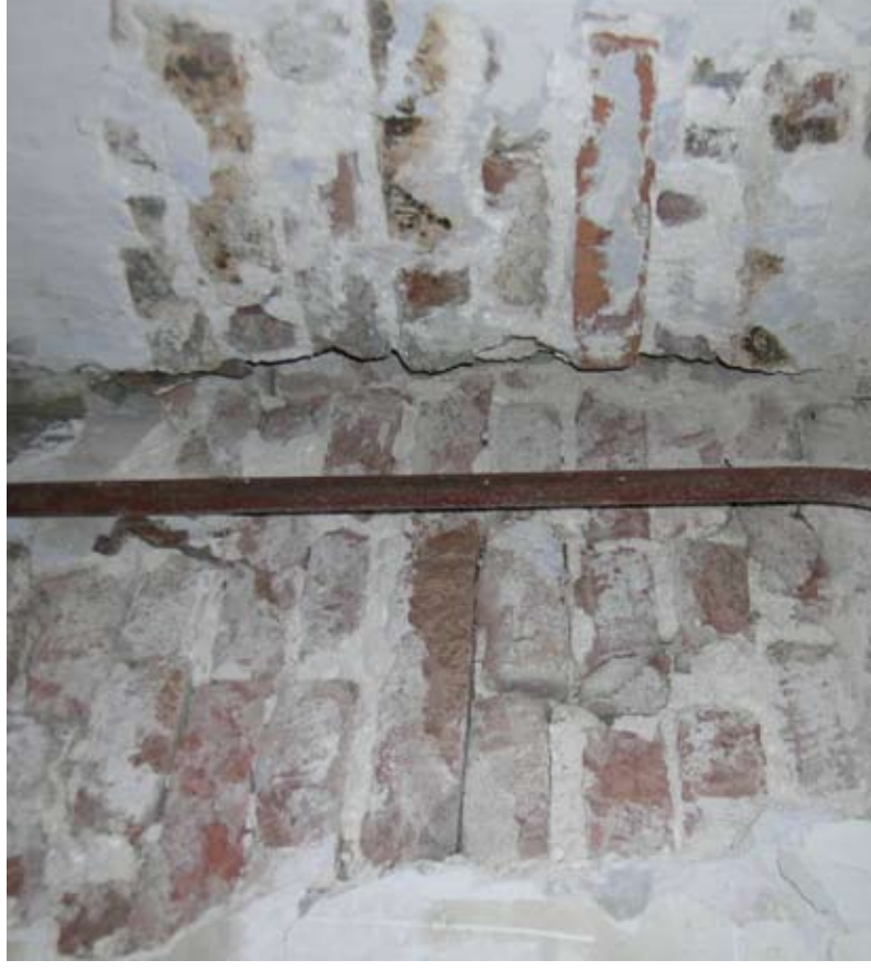
Afbeelding 15. Bouwspoor 18. Links het metselwerk van de borstwering van de voorgevel van het voorhuis (22,5/23 x 11 x 4 cm met een tienlagenmaat van 50 cm), en rechts de brandmuur (steendikte 4,0-4,5 cm en een tienlagenmaat van 54 cm), die koud tegen elkaar staan.
