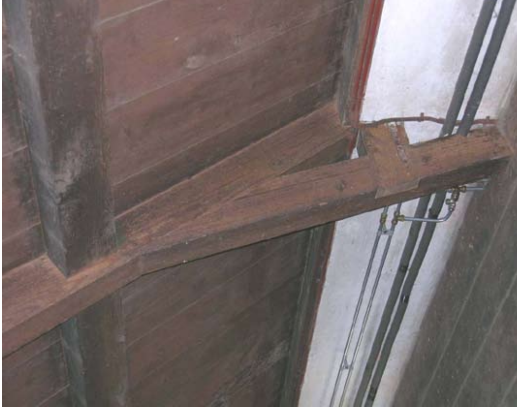
Afbeelding 143. Detail van de vorige afbeelding met de grenen kaspanten. De kap kent geen telmerken of hergebruikt hout en werd in één bouwfase in de late 19 de eeuw aangebracht.
