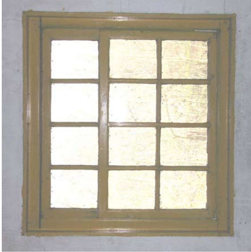
Afbeelding 144. Detail van de eervorige afbeelding met het zolderraam met fijne roedenerdeling. Het raam is mogelijk hergebruikt tijdens de bouwactiviteiten in de late 19 de eeuw.
