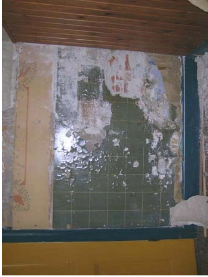
Afbeelding 116. Detail van de hpl-bekleding met tegelpatroon uit de jaren '50 of '60 van de 20 ste eeuw aan de zijde van de middengang in de keuken.
