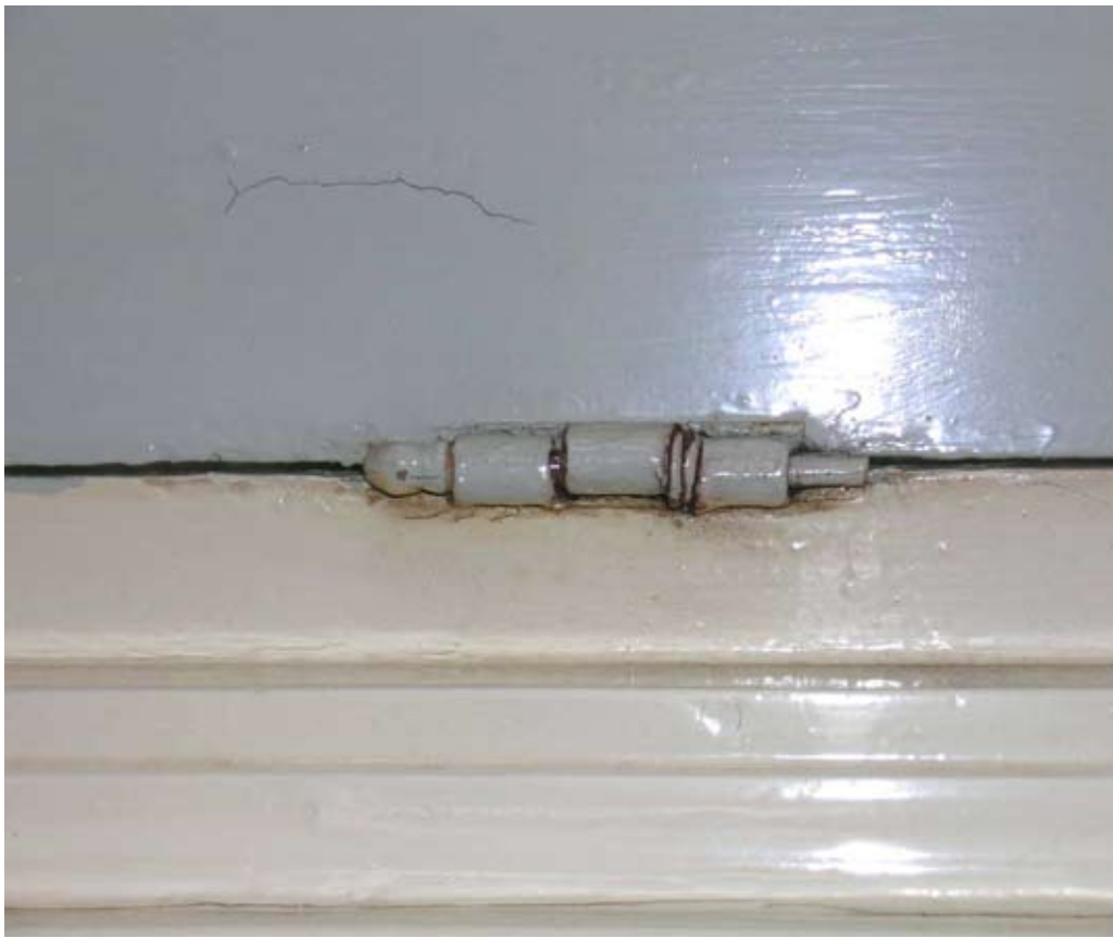
Afbeelding 83. Detail van de eervorige afbeelding met één van de laat 19 de -eeuwse scharnieren.
