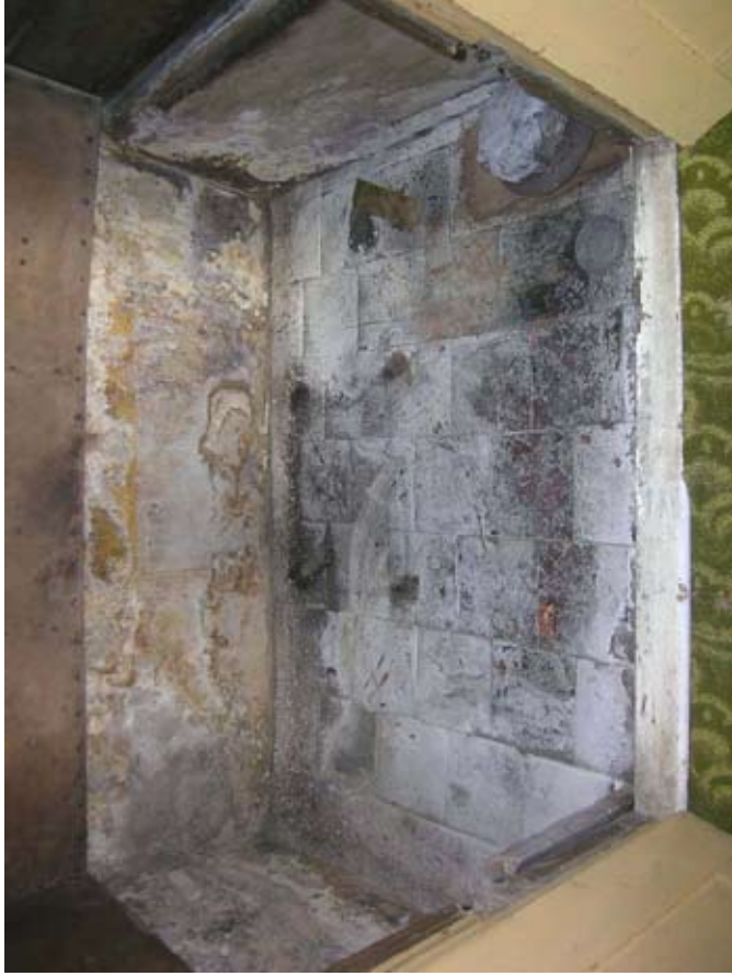
Afbeelding 78. Zicht in de linker kast cq. linker bedstede met plavuizenvloer.
