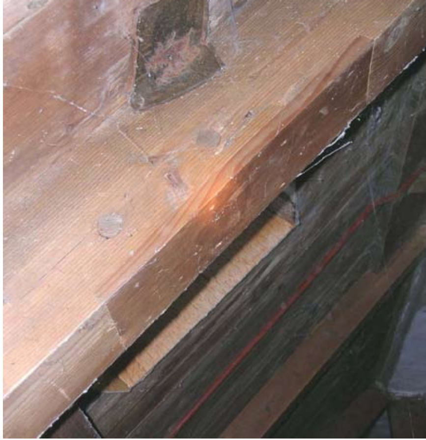
Afbeelding 136. Detail van het kapsant boven de zoldertrap in het voorhuis. De twee toognagels en de uitstukking geven de plaats aan van de vroegere kreupele stij. Deze is vermoedelijk verwijderd, toen de huidige luie zoldertrap werd aangebracht ter ontsluiting van de – vermoedelijk in de jaren '30 – ingebrachte secundaire zolderkamer(tjes).
