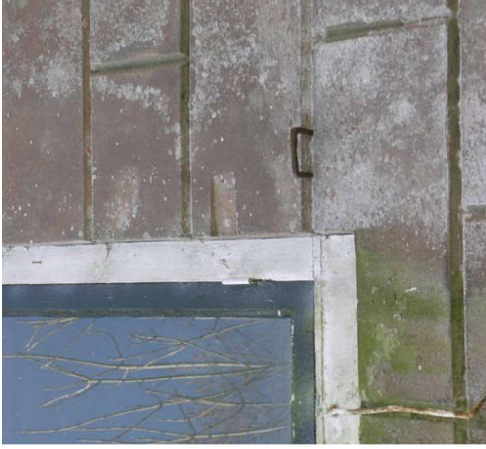
Afbeelding 49. Detail van de vorige afbeelding, met sporen in het geblokte pleisterwerk van de uitkepingen van de gehengen van de luiken.
