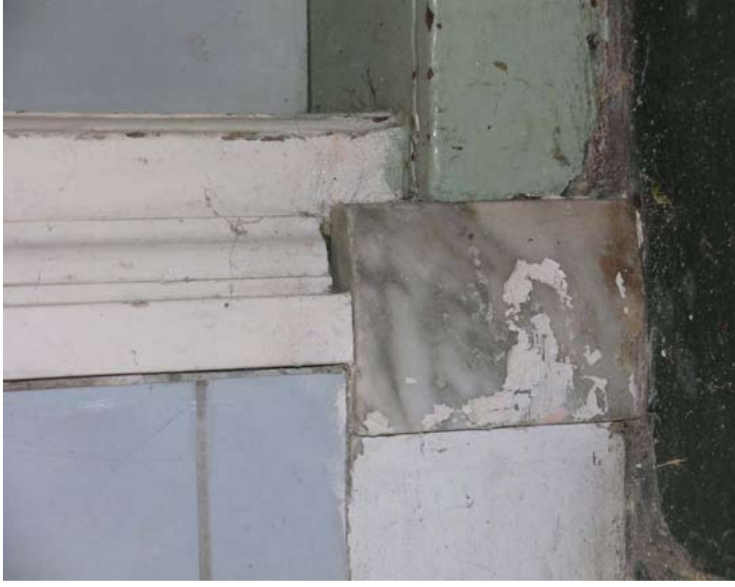
Afbeelding 71. Detail van de plint, die uit geschilderd witmarmor bestaat.
