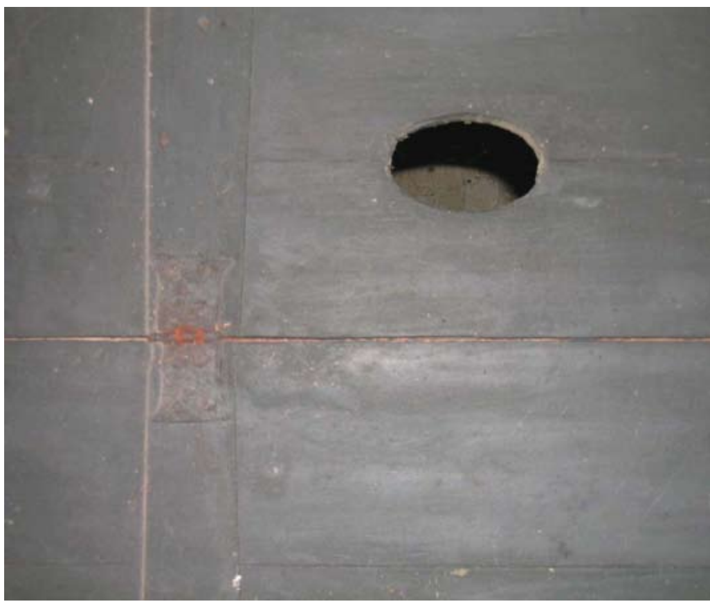
Afbeelding 99. Detail van de vorige afbeelding met ovale ventilatieopening en knier.
