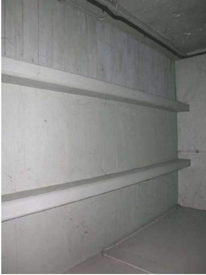
Afbeelding 110. Enkelvoudige balklaag boven de bijkeuken.
