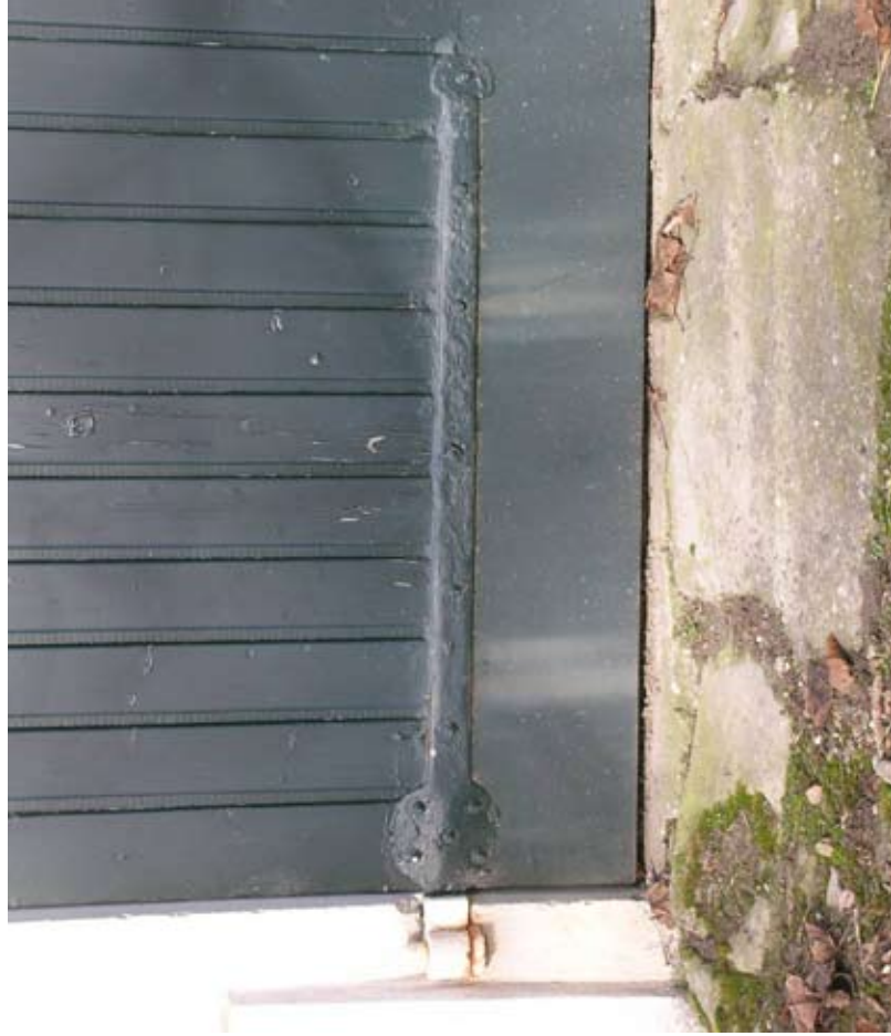
Afbeelding 40. Detail van het traditionele smeedijzeren deurgeheng van één van de koetshuisdeuren.
