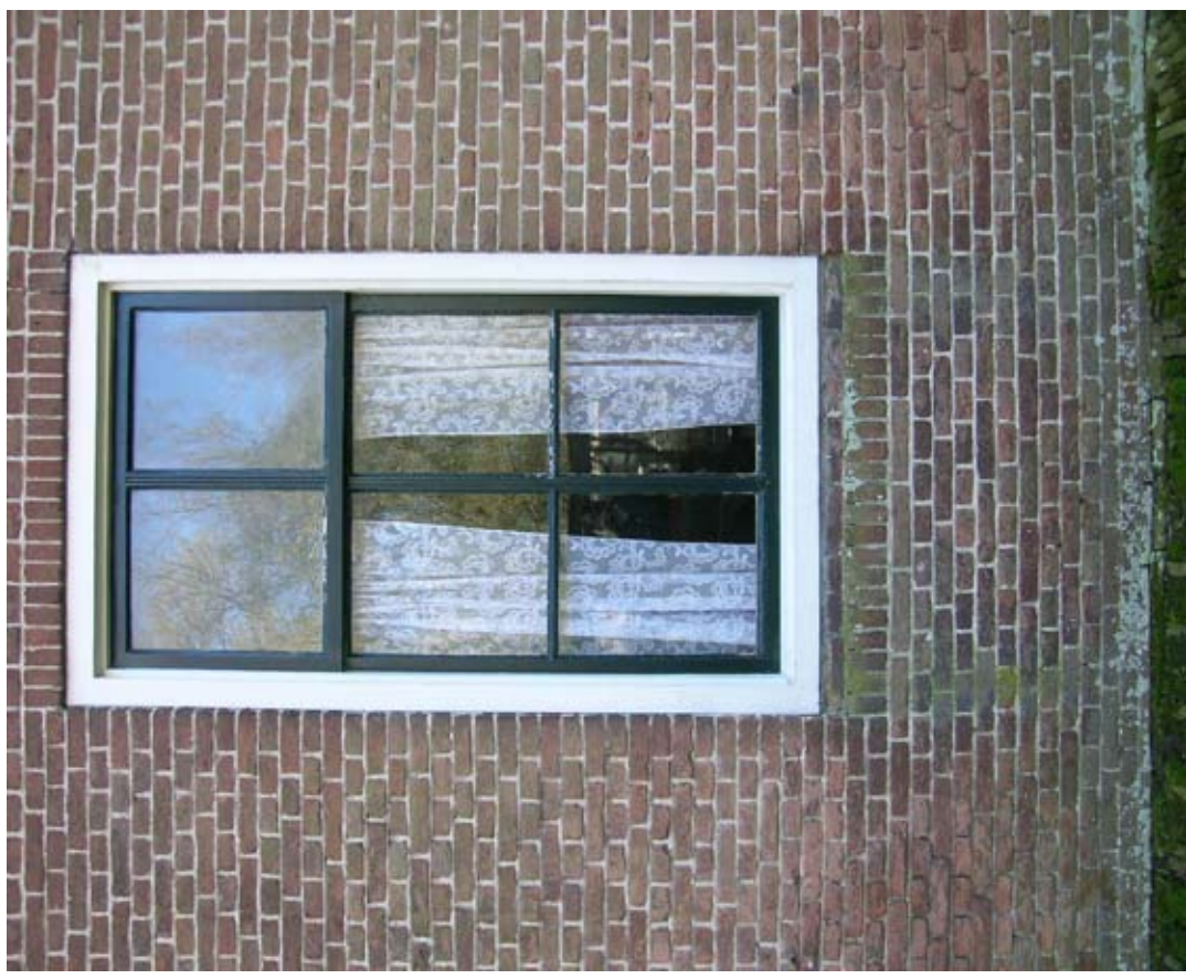
Afbeelding 55. Detail van één van de schuiframen met 6-ruits roedenverdeling.
