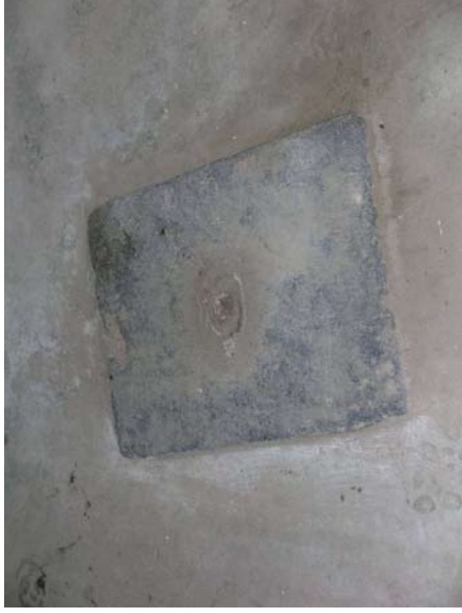
Afbeelding 97. Hardstenen grondplaat op de poer onder de voormalige middenstijl in het koetshuis.
