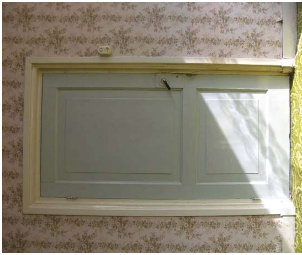
Afbeelding 81. Detail van de paneeldeur van de linker woonkamer.
