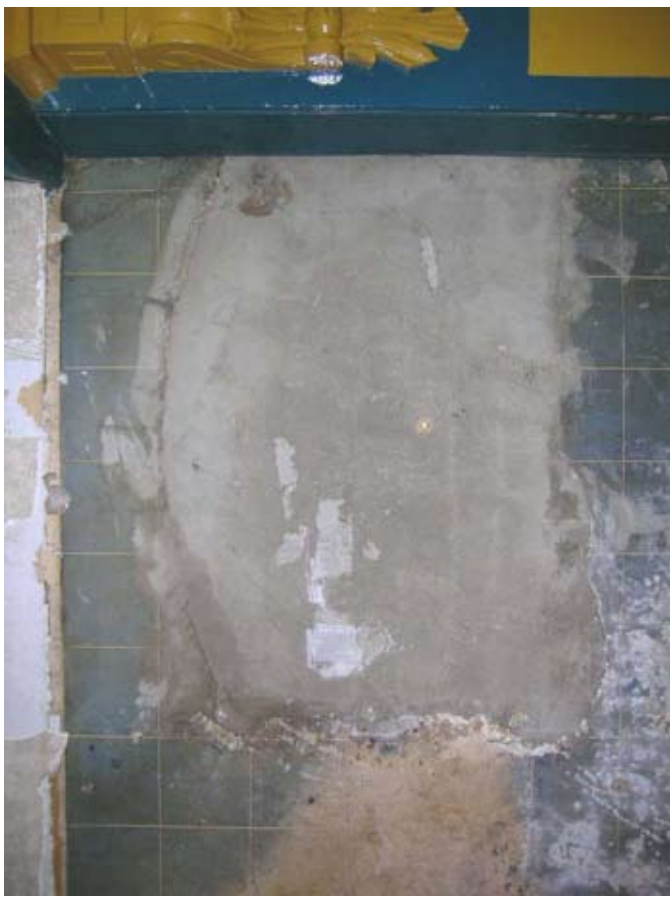
Afbeelding 115. Detail van de dichtgezette opening van de achterliggende bakoven.
