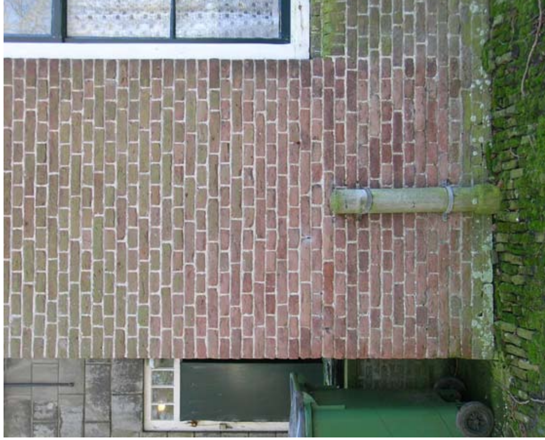
Afbeelding 61. Detail van de hoekoplossing met de drieklezoren.
