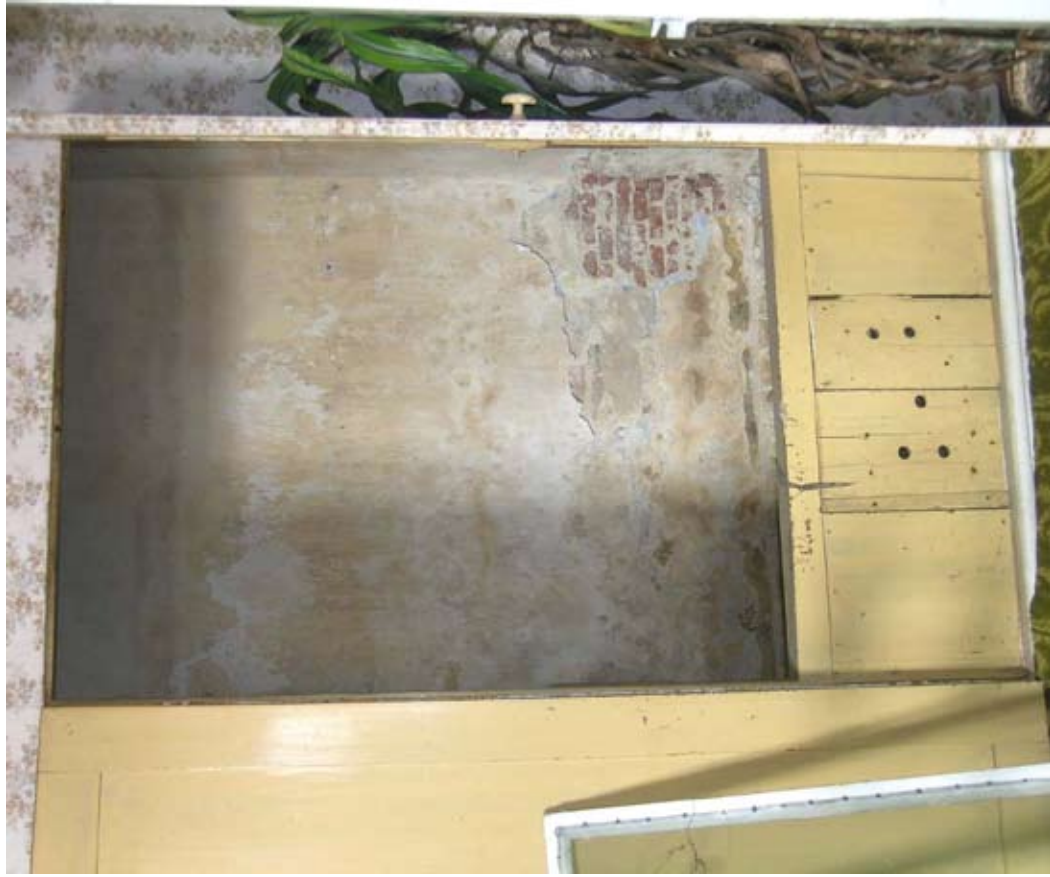
Afbeelding 80. Zicht in de rechterkast of bedstede met ventilatiegaten in het schot aan de onderzijde.
