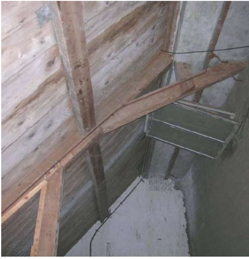
Afbeelding 139. Zicht in de kap boven de paardenstal.
