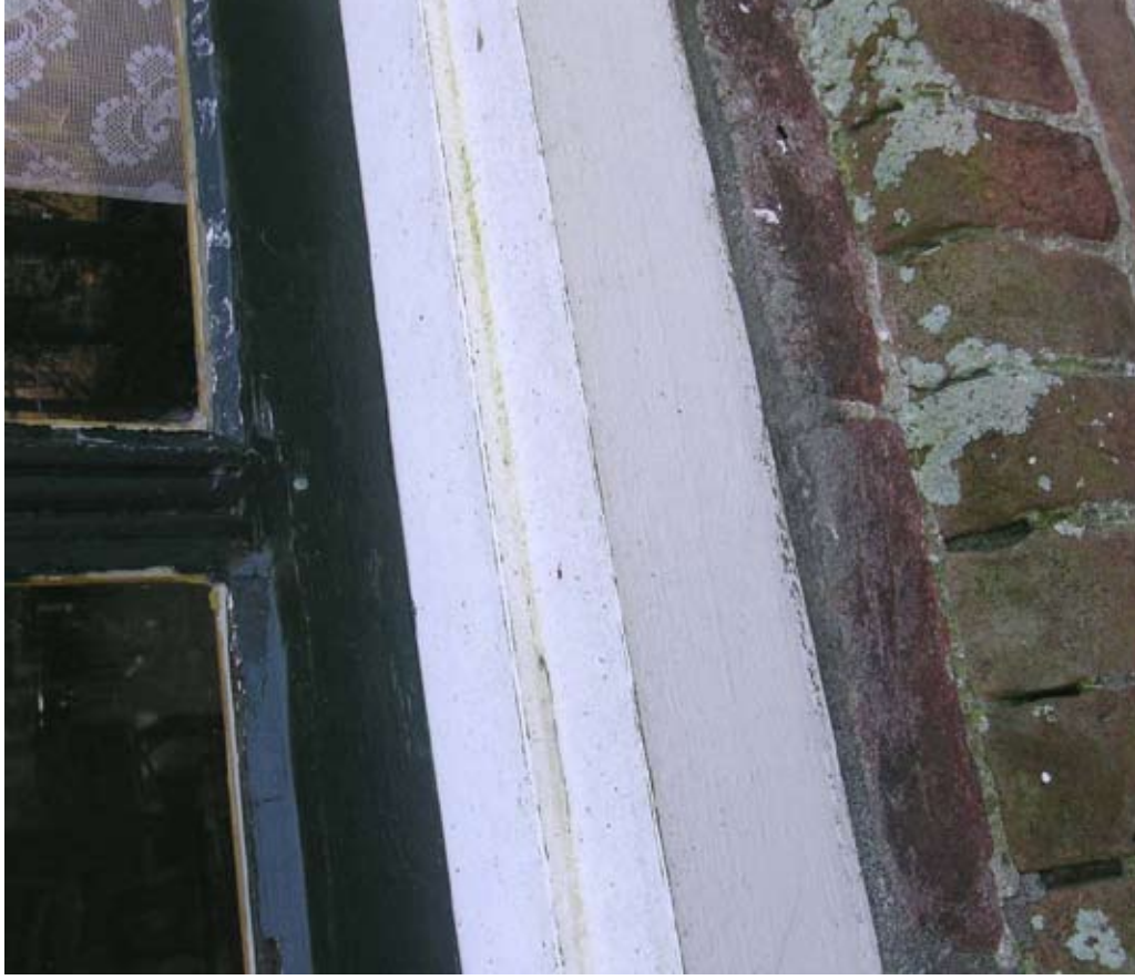
Afbeelding 56. Detail van de vorige afbeelding met rollaag onder het kozijn.
