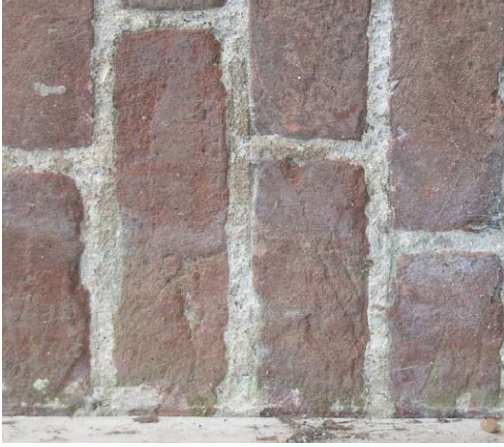
Afbeelding 63. Detail van de vorige afbeelding met restanten van de oorspronkelijke gesneden voegen. Het metselwerk bestaat uit bakstenen van 21,5 x 10,5 x 5 cm met een tienlagenmaat van 59 cm (bouwspoor 7).
