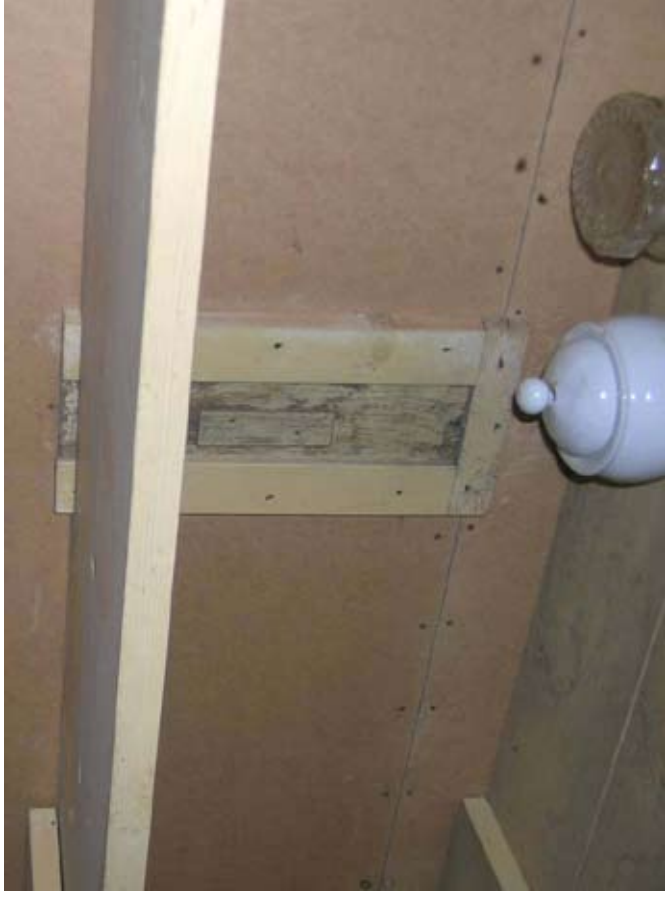
Afbeelding 89. Detail van het schuifje van de licht- of luchtspleet in de bedstede met zicht in het voormalige koetshuis.
