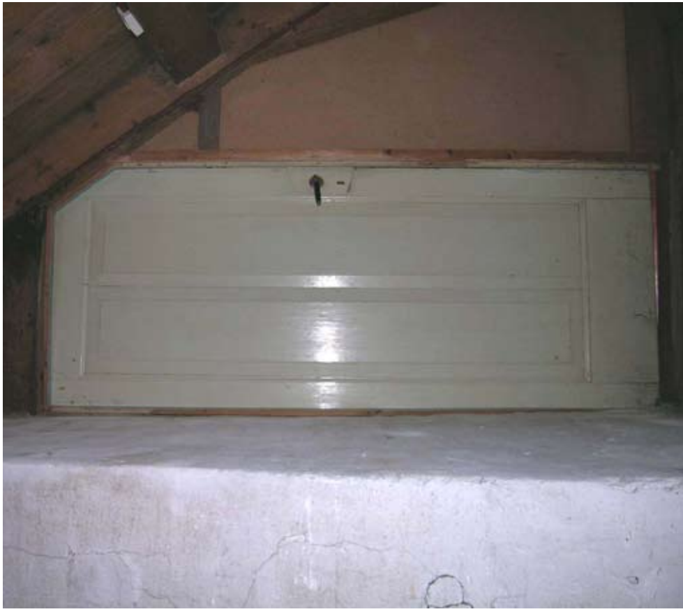
Afbeelding 149. Detail van de uit twee slanke panelen samengestelde zolderdeur. De panelen staan koud tegen elkaar aan en zijn vermoedelijk hergeboukt.
