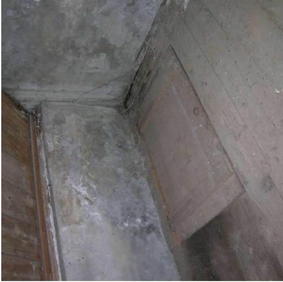
Afbeelding 140. Detail van het vloerluis op de hooizolder boven de paardenstal.
