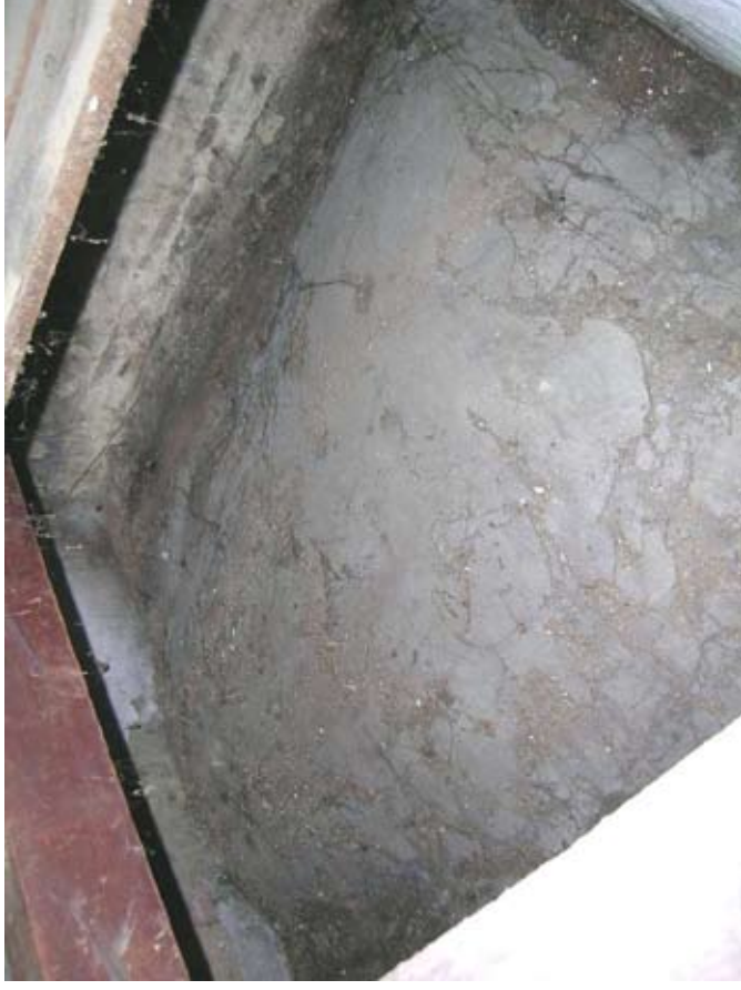
Afbeelding 111. Zicht op de bovenzijde van het tongewelf van de bakoven. Deze was oorspronkelijk toegankelijk vanuit de aangrenzende keukenruimte.
