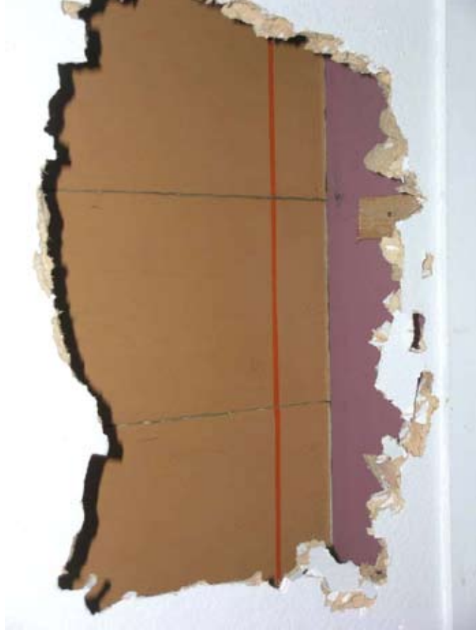
Afbeelding 90. Detail van het boardplafond en de balklaag met rode bies op de vloerdelen erachter.
