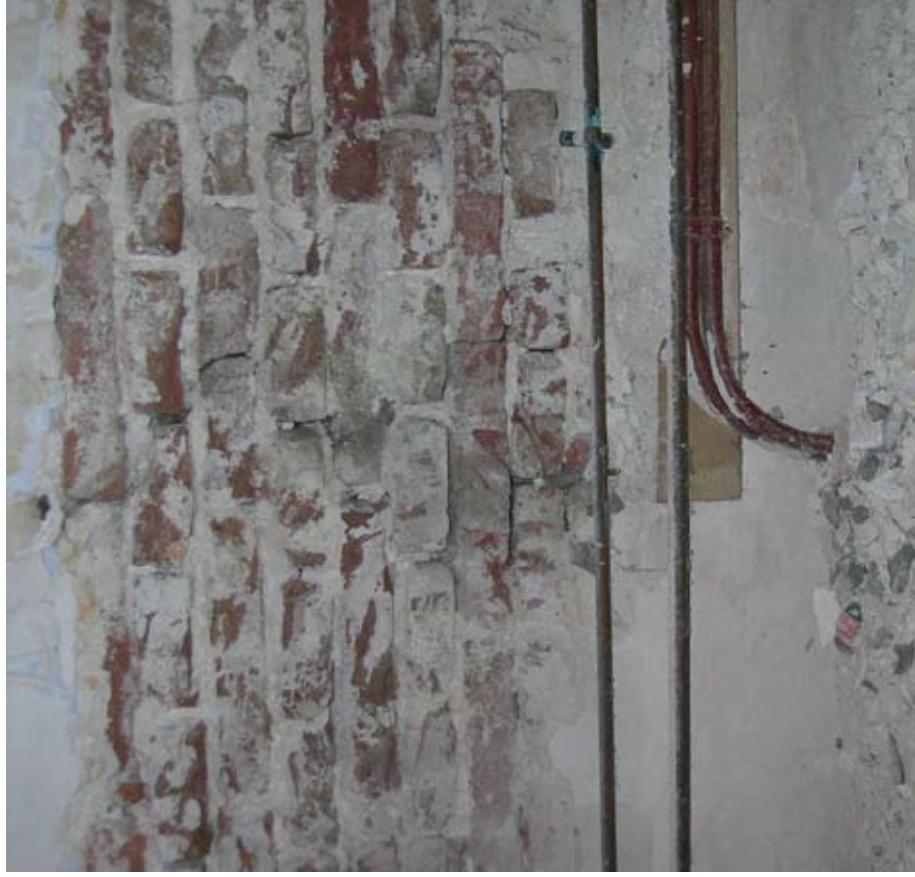
Afbeelding 17. Bouwspoor 19. Het metselwerk van de borstwering van het voorhuis op zolder (22,5/23 x 11 x 4 cm met een tienlagenmaat van 50 cm).
