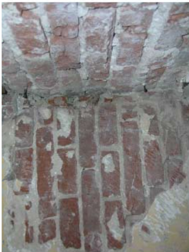
Abbeeking 5. Bouwspoor 4. Links het metselwerk van de achtermuur van het voorhuis (sieraansluiting 4,25 cm met een sieraansluiting van 54 cm) en rechts de hierin ingebaste zijgevel van het achterhuis (sieraansluiting 4,5 cm met een sieraansluiting van 62 cm).
