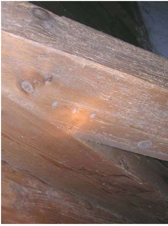
Afbeelding 135. Detail van één van de kreupele stijlen met het gehakte telmerk 000. Deze stijl is vermoedelijk afkomstig van de voorganger van het huidige pand en in de late 19 de -eeuwse huidige kap hergebruikt.
