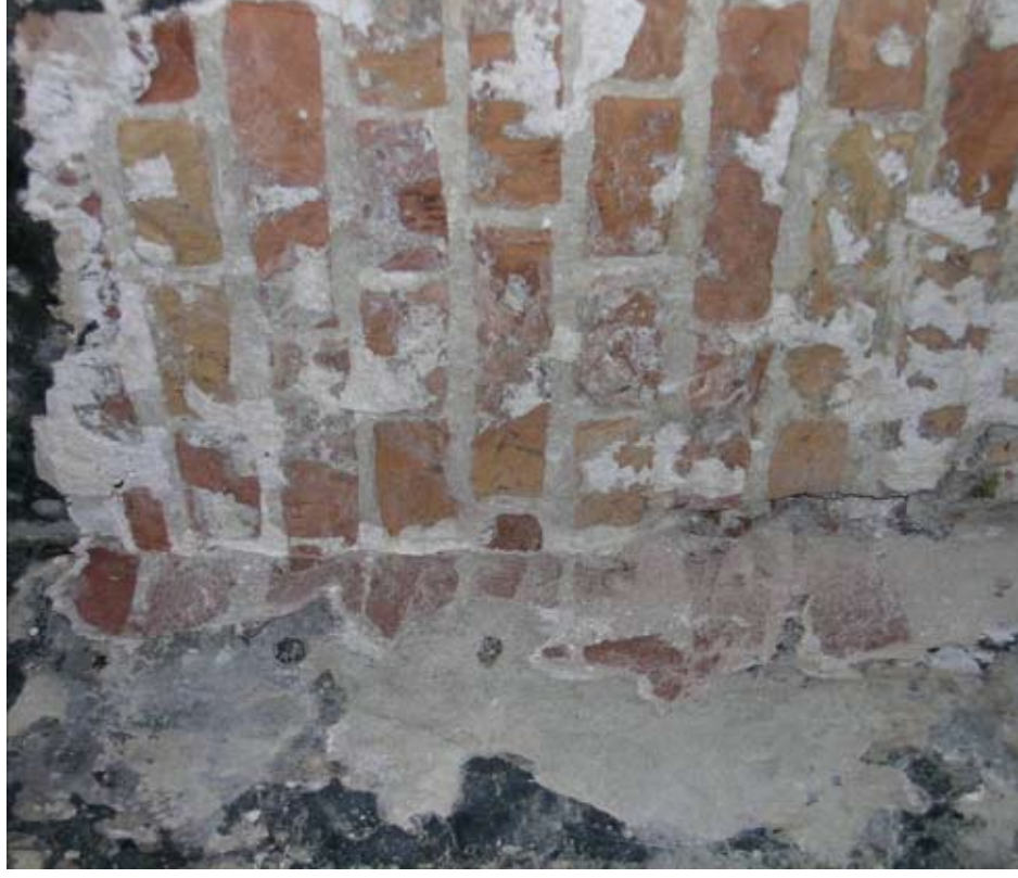
Afbeelding 7. Bouwspoor 9. Rechts het metselwerk van de bouwmuur aan de zijde van het woonhuis (18 x 8,5 x 4,5 cm met een tienlagenmaat van 54 cm) en links de voorgevel (met een tienlagenmaat van 54 cm), die in de bouwmuur is ingekast.
