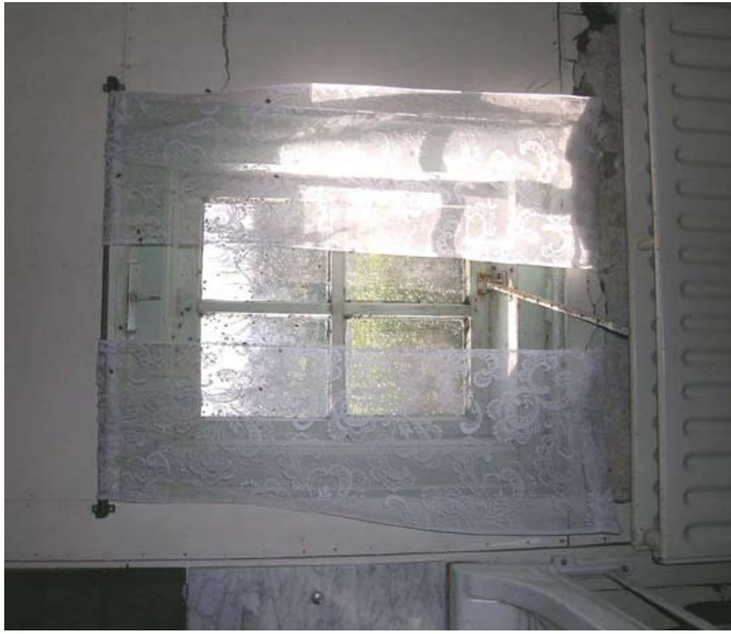
Afbeelding 151. Detail van de vorige afbeelding met het vierruits zolderraam.
