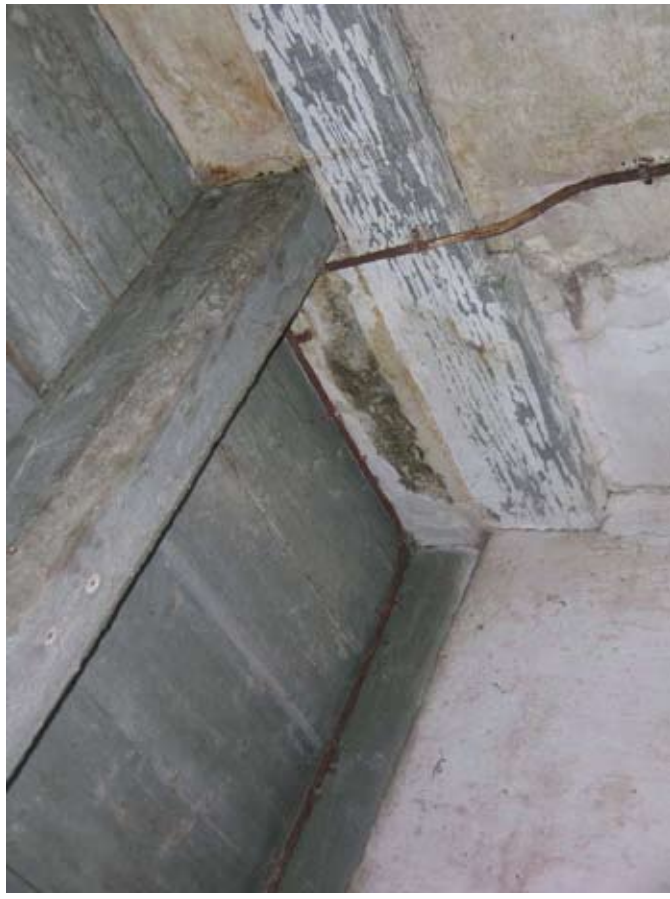
Afbeelding 93. Detail van de vorige afbeelding met de houten latei aan de bovenzijde van de voormalige grotere doorgang.
