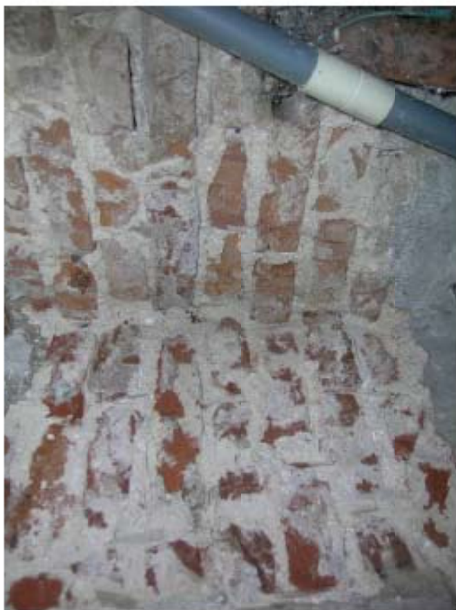
Abbeeking 4. Bouwspoor 3. Rechts het metselwerk van de gangmuur (17,5 x 11,5 x 4 cm met een sieraansluiting van 54 cm) en links de voorgewal (17 x 8,5 x 4,5 cm met een sieraansluiting van 54 cm), die in de gangmuur is ingebast.
