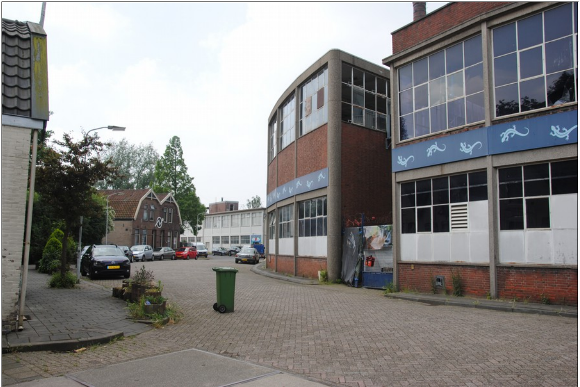
Afbeelding 2. Overzicht van een deel van het plangebied aan de Oostzijde (Oostzijde 367-375). Het linkergebouw met de blauwe met salamanders of hagedissen versierde band zal blijven bestaan en is diep onderkelderd. Daarom is hier niet geboord. In het rechtergebouw en in de steeg is wel geboord. Het witte gebouw achteraan is Oostzijde 353-355-365. Er tussen, niet zichtbaar op de foto, ligt Oostzijde 359-361. De twee woonhuizen links op de foto zijn Oostzijde 380 en 382. Foto richting zuidwesten.
