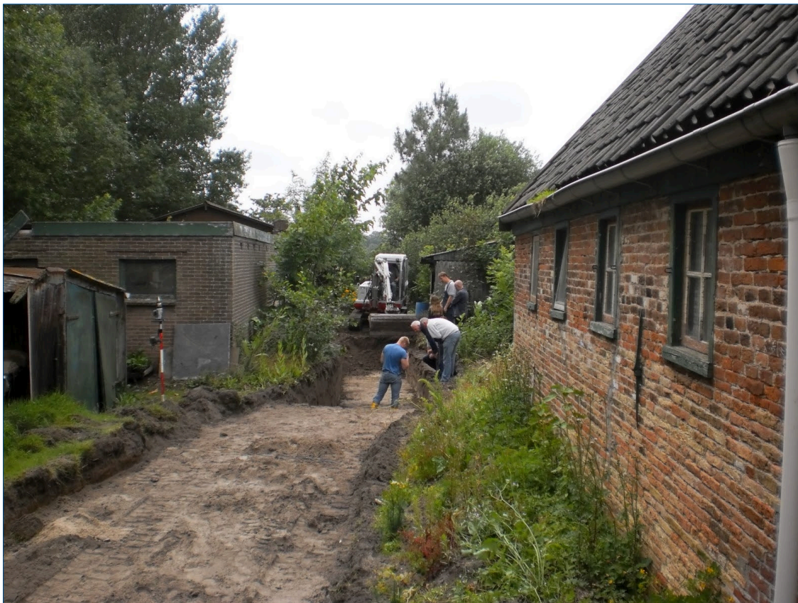
Figuur 12. Overzicht van de werkomstandigheden en beperkte werkruimte ter plaatse van per-ceel Benedenweg 212 bij de aanleg van WP2. De foto is genomen richting het westen (foto: S. Balder).
