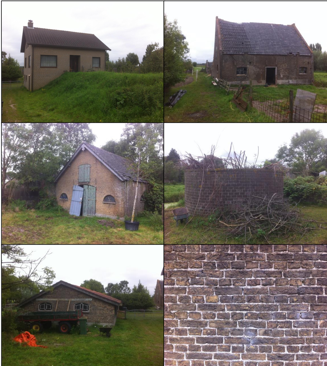
Figuur 12: Foto's van het plangebied en de verschillende bouwwerken in het plangebied ten tijde van het veldonderzoek. Rechtsonder, Hollands verband in IJsselsteen.
