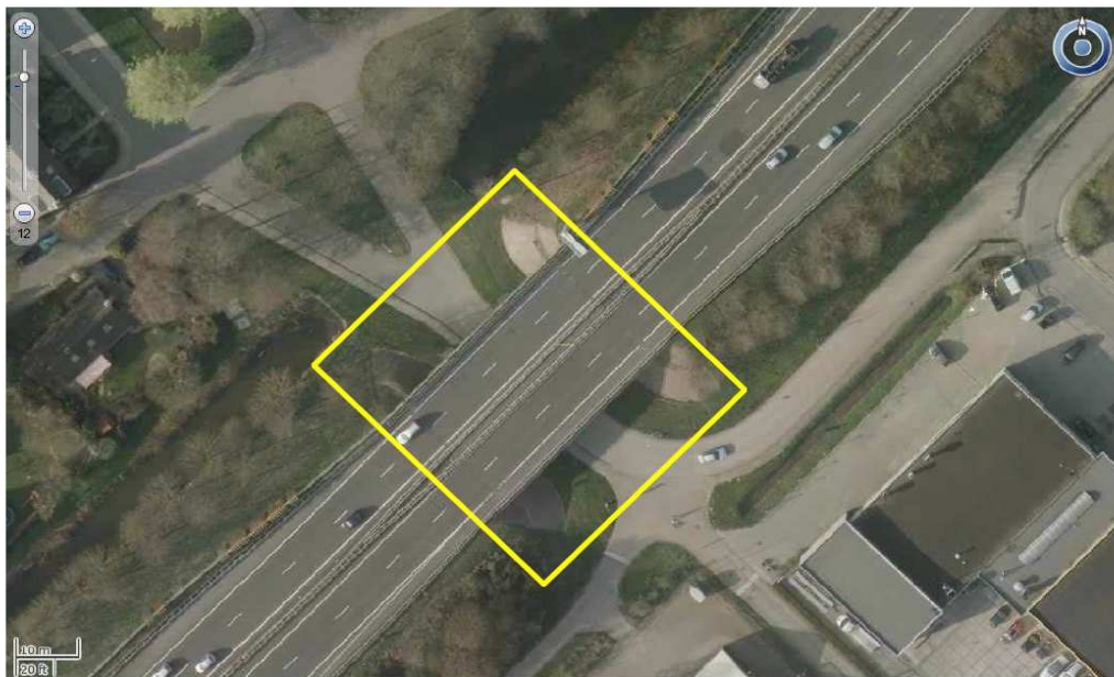
Locatie 2 Viaduct Biljoen
