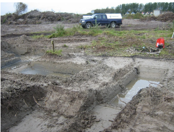
Afbeelding 3.4 Sleuven gezien in noordelijke richting
