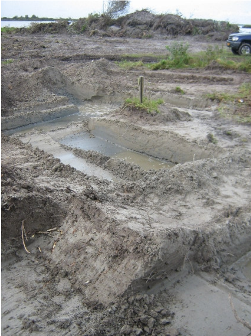
Afbeelding 3.2 Overzicht van de gegraven sleuven in noordwestelijke richting. Rechts van het bordje bevindt zich de voormalige kampvuurplaats. Achter het bordje bevond zich de afgegraven wal.
