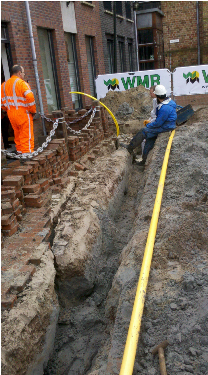
Figuur 18. Dokkum, Markt 2a & 2b: Foto van het zuidelijke deel van de sleuf, genomen richting het zuiden. Op de achtergrond is de Martinuskerk zichtbaar, in het midden de scheur in het profiel.
