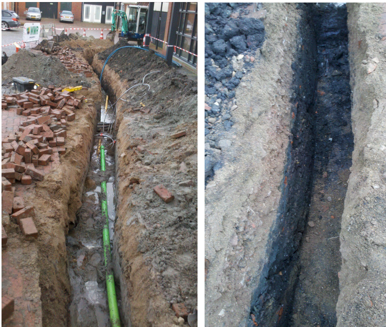
Figuur 21. Dokkum, Markt 2a & 2b: Beide foto's zijn genomen richting het noorden. De linker foto laat een overzicht zien van het midden en noordelijke deel van de sleuf. Hierop is te zien dat de grond uit opgebracht zand bestaat en in het noorden uit een donkere verstoorde laag. De rechter foto laat deze laag in het vlak zien.
