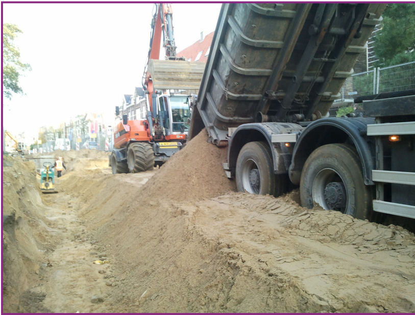
Afbeelding 20. De werkput wordt direct na het leggen van de vernieuwde riolering aangevuld met schoon zand, gezien in de richting van het noordwesten.
