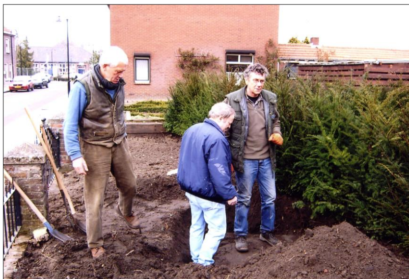
Fig. 5. De locatie van de put, naar het noorden gezien.
