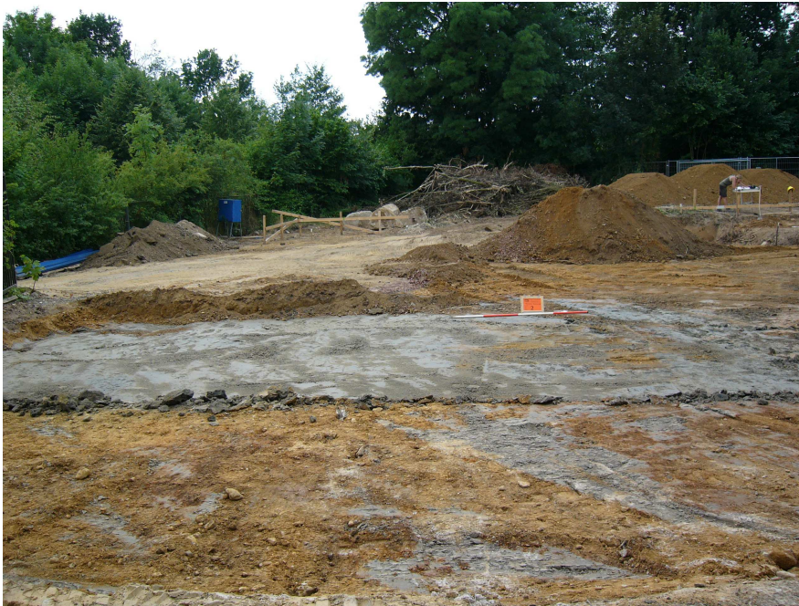
Afbeelding 2.3 Overzicht van het opgebrachte grindpakket in werkput 1 en 2. Foto: B. Silkens.
