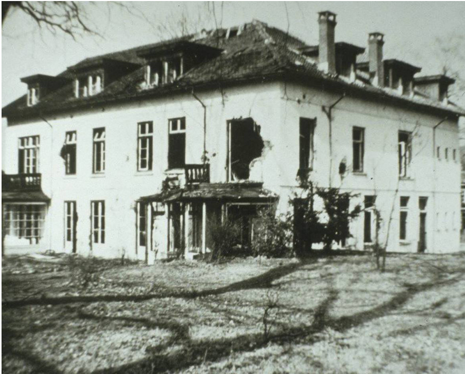
Figuur 2.13 Schade aan de achterzijde van het hotel, veroorzaakt door Brits vuur op Duitse infiltranten.
