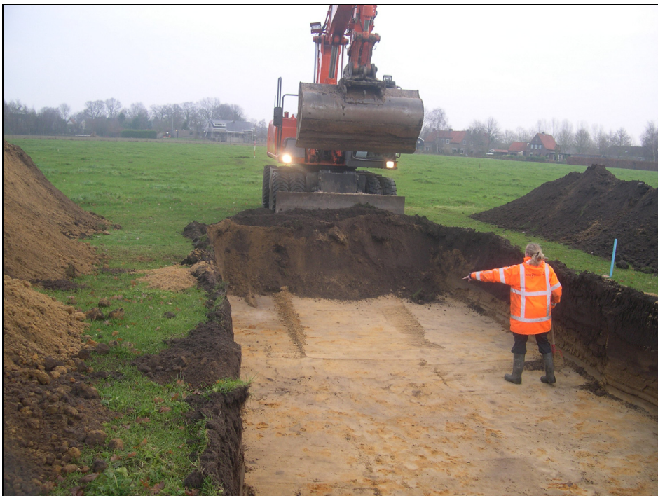
Afb. 3. Aanleg van het vlak.
