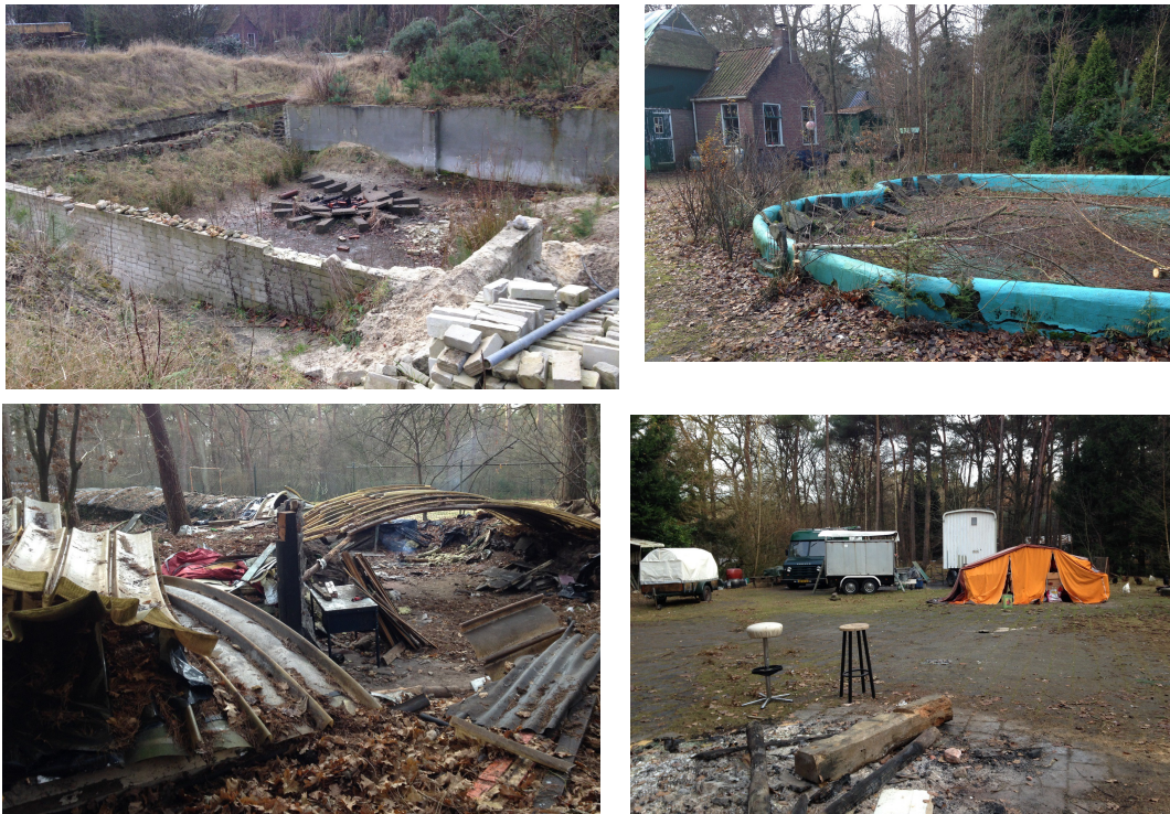
Figuur 3: Norg, Vluchtheuvel: Foto's van het onderzoeksgebied. De foto linksboven is genomen in het westelijke deel van het plangebied, richting het zuidwesten, en laat een deels afgebroken gebouw zien. De foto rechtsboven is eveneens in het westelijke deel genomen, richting het zuidwesten, met op de voorgrond een zwembad en op de achtergrond het voormalige pannenkoekrestaurant. Linksonder is een foto in het zuiden genomen, richting het westen. Hierop is een deels nog overkapte ingraving te zien. De rechterfoto is genomen in het centrale deel van het plangebied, richting het zuidoosten. Deze foto is genomen ter hoogte van een plein.
