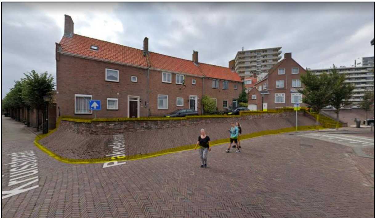
Figuur 10: Het zuidelijk deel van de keermuur in de huidige situatie (bron: Google Streetview). De keermuur is geel omlijnd. De bebouwing achter de keermuur betreft Pakveldstraat 2 t/m 6.
