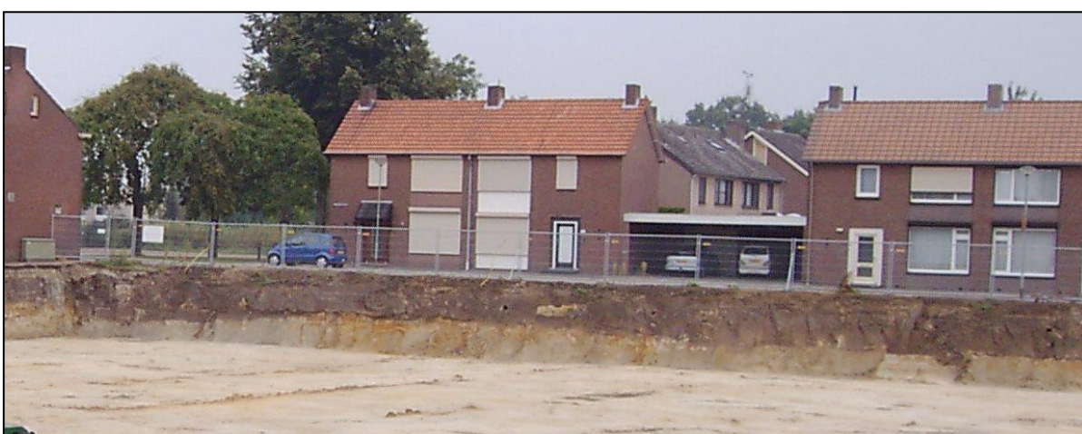
Fig. 21. Profiel van de oostzijde (Moesemansstraat). Foto A. Bruekers.
