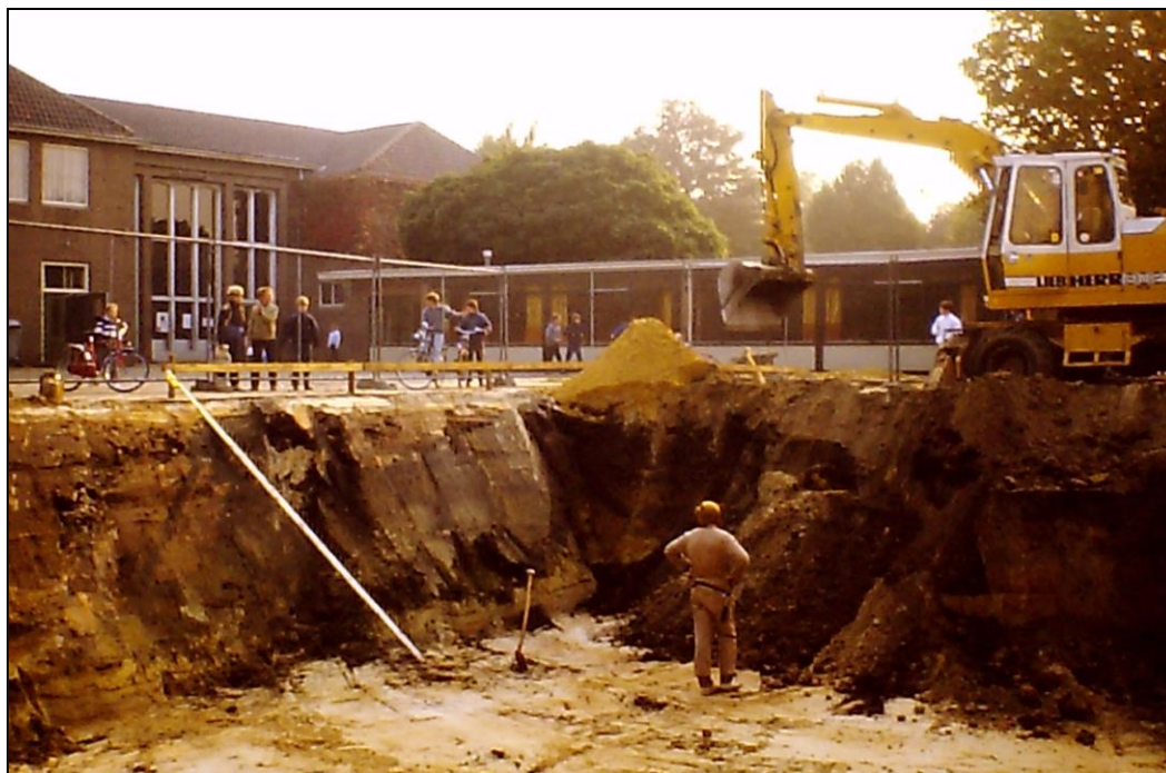
Fig 5. Aanleg van de bouwput. Op de achtergrond de (voormalige) St. Lambertusschool. Foto: A. Bruekers.
