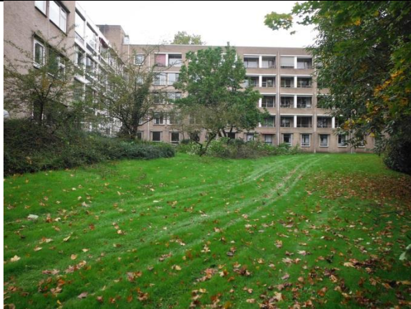
Vanuit zuidelijke richting nabij boring 9
