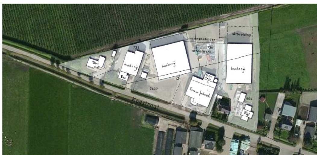
Figuur 2: Voormalige (boven) en bestaande (te legaliseren) situatie (onder).
