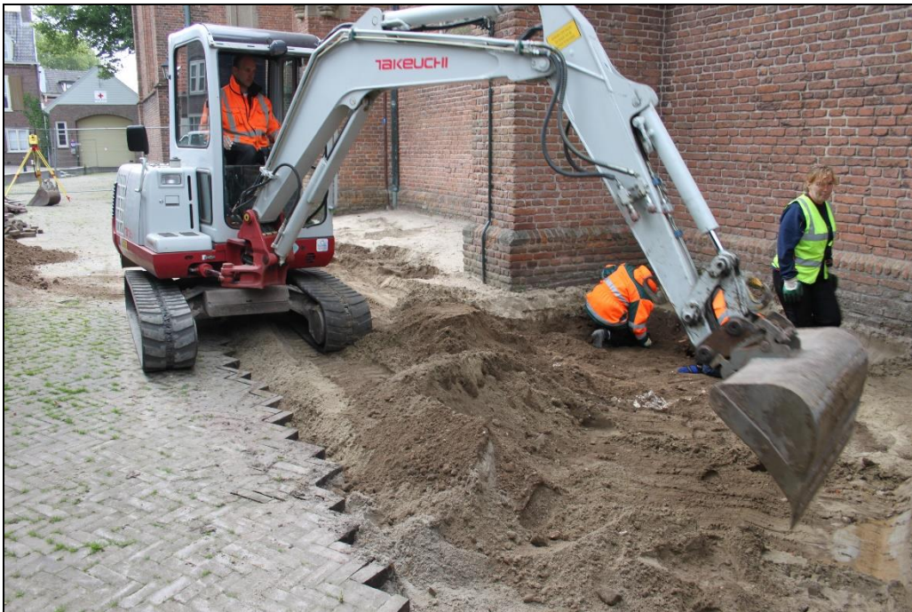
Figuur 4. Sfeerfoto aanleg werkput 1.
