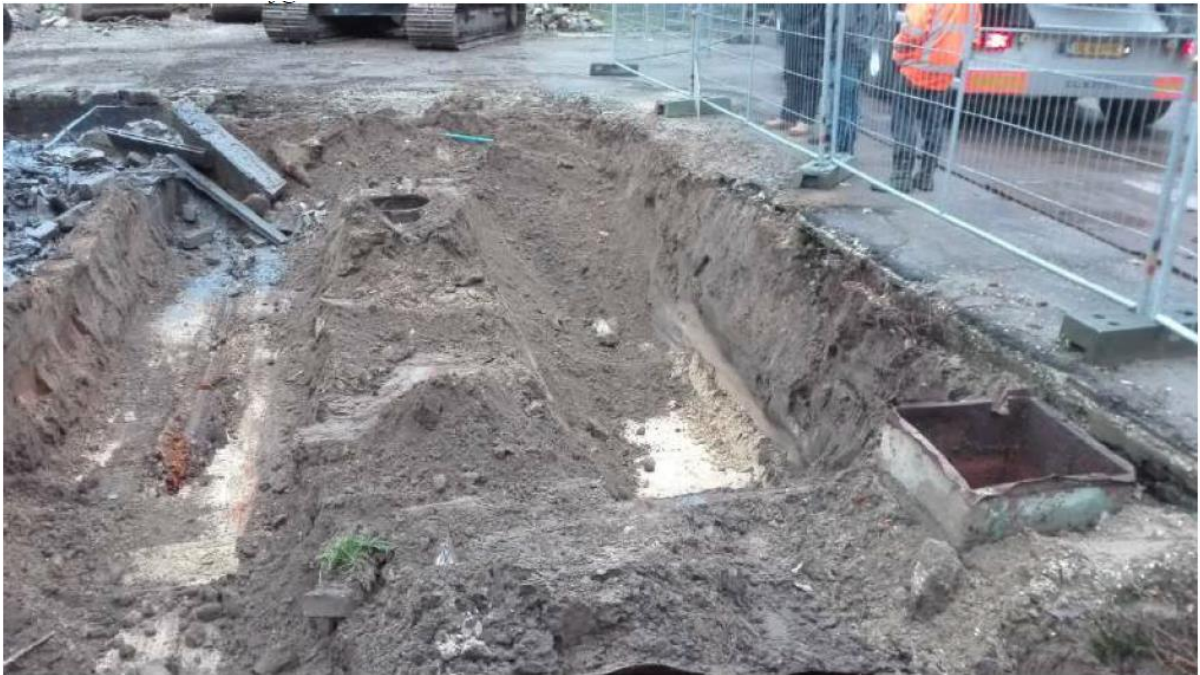
Figuur 10. Foto's van de in het plangebied uitgevoerde tanksanering 36
