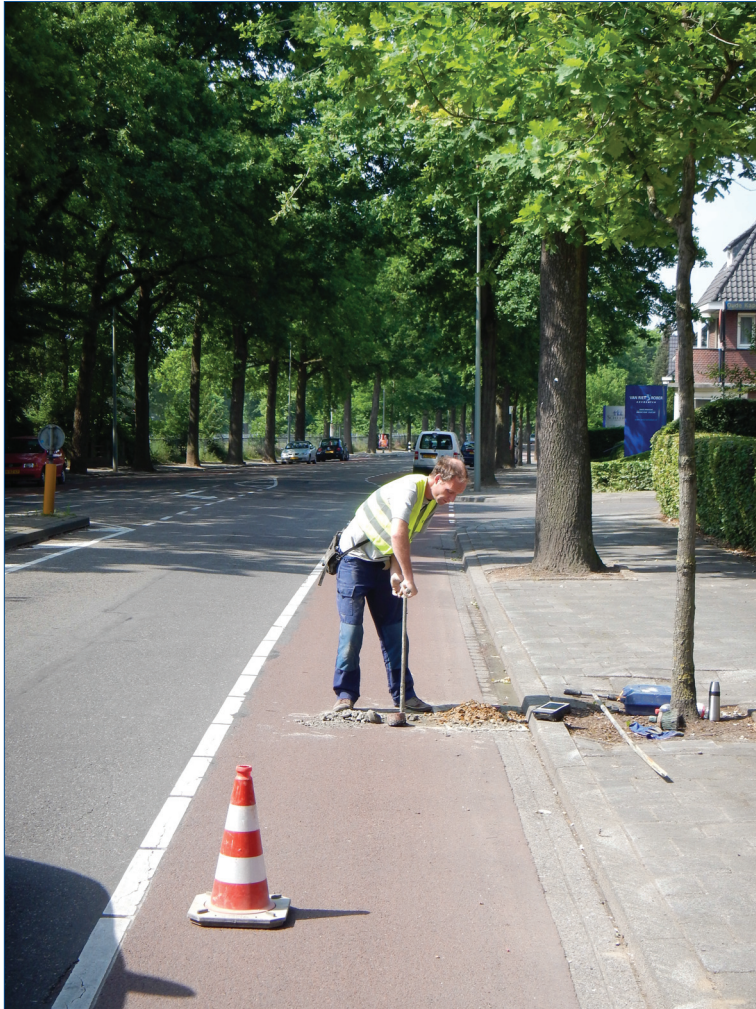
Figuur 9. Nadat het asfalt en stol was verwijderd, zijn handmatige boringen gezet.
