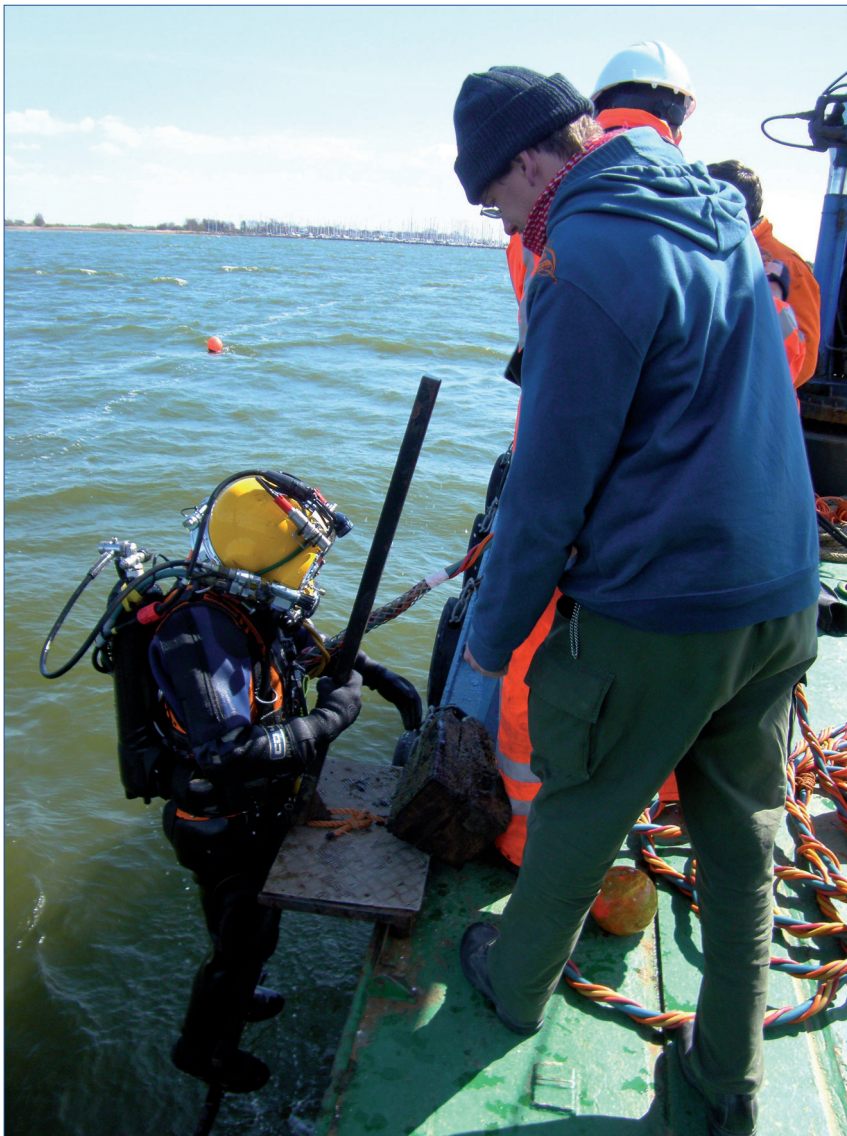
Figuur 3. De duiker gaat te water. Op de duikhelm zijn lamp en videocamera te zien.
