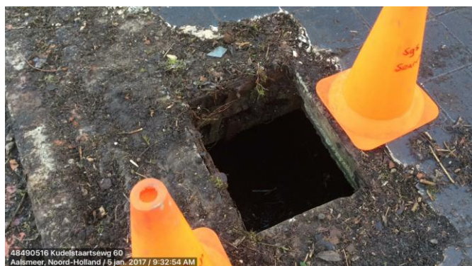
Figuur 7: Foto van het luikgat in de betonvloer van het voormalige gebouw.
