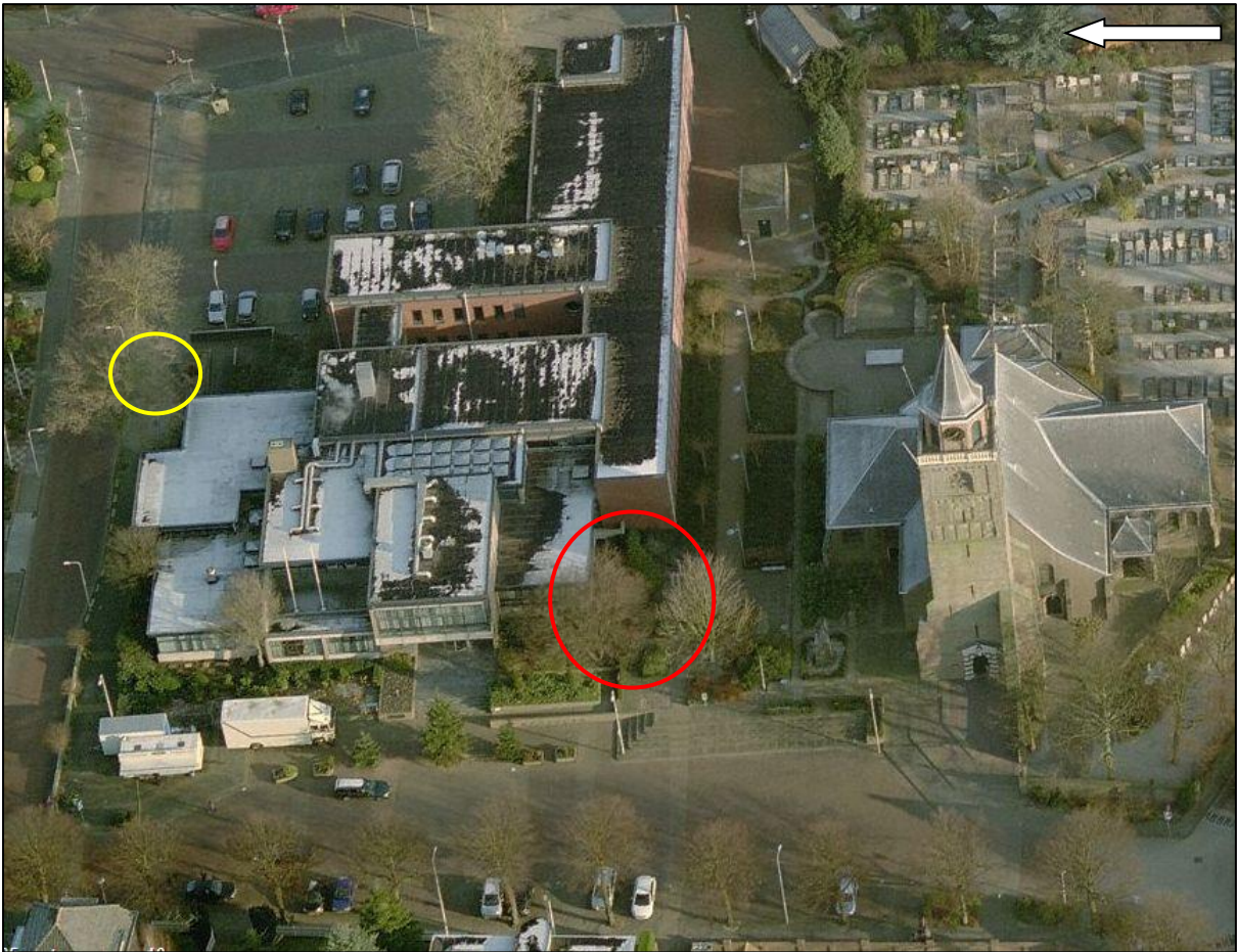
Figuur 1: Het plangebied voorafgaand aan het veldwerk (bron: Bing Maps). In het rood de locatie van werkput 1 tot en met 3 en in het geel de locatie van werkput 4.
