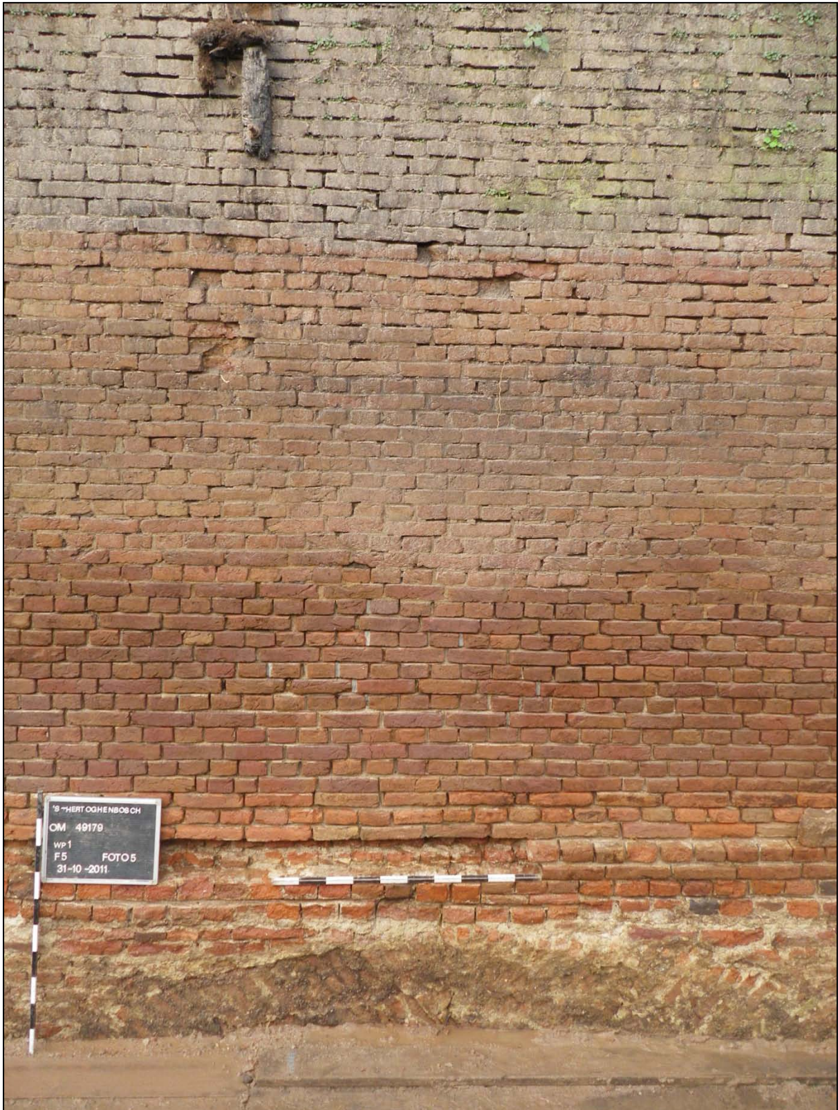
Figuur 10: Klampmuur met onderaan een grondboog.
