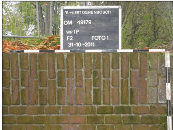
Figuur 8: Borstwering met verticaal koppen- en strekkenverband. Er onder is nog een deel van F3A te zien (zie Hfst. 6.2)
