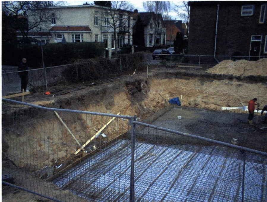
Afbeelding 2: het uitgegraven keldergat
