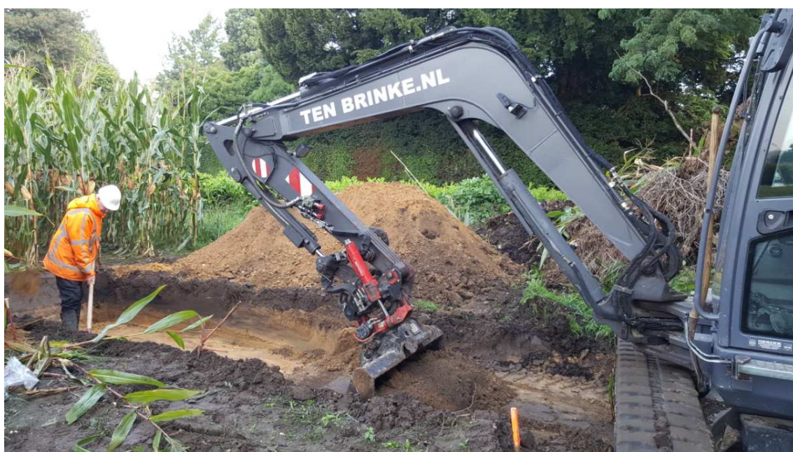
Afbeelding 1 Impressie proefsleuvenonderzoek. Aanleg werkput 1, gezien richting het noorden. Bron: foto Vestigia (12-09-2017).
