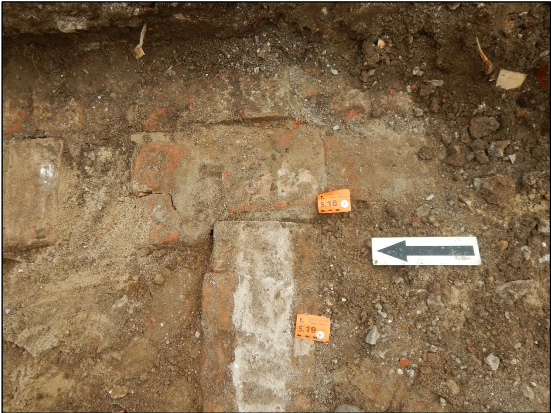
Figuur 19. Spoor 19 is uitgebroken voor de bouw van spoor 18. Spoor 18 is netjes om spoor 19 heen gemetseld.
