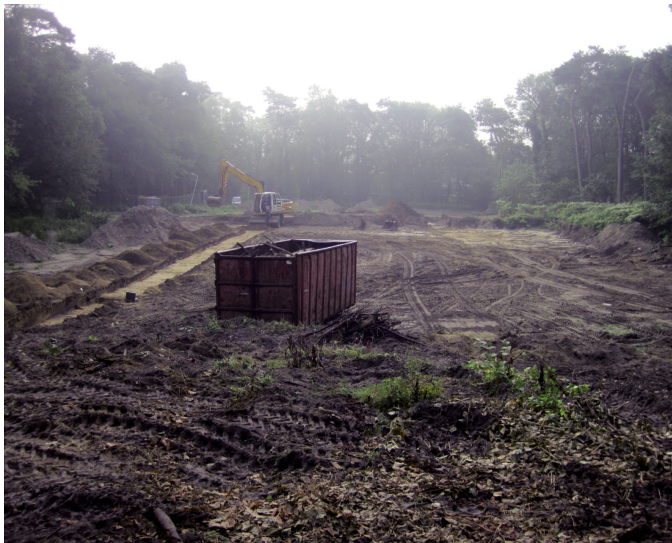
afbeelding 87, het onderzoeksgebied tijdens het aanleggen van de eerste proefsleuf.
