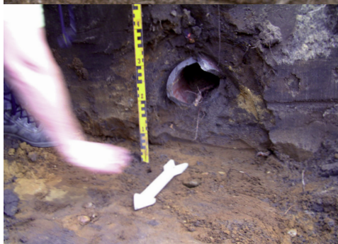
afbeelding 35, grespijpriool met doorsnede van 18 cm.
