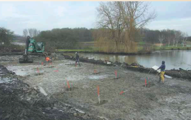
De verticale jalons markeren de paalkuilen van het gebouw. Foto: Gemeente Rijswijk/Archeologie
