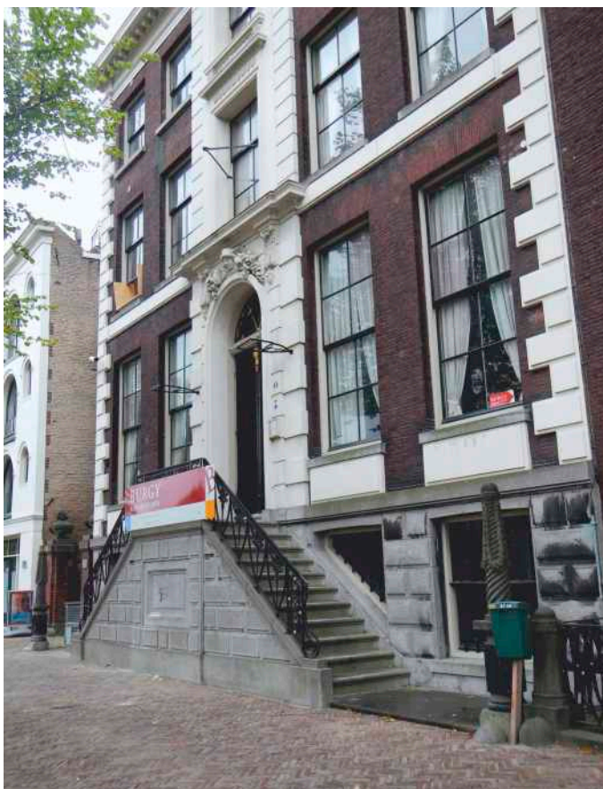
Het monumentale pand Huis Nolet tijdens de restauratie. (Foto: BOOR)
