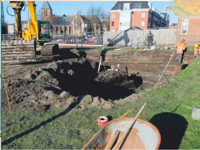
Impressie van het veldonderzoek. Aan het maaiveld is duidelijk de toenemende dikte te zien van de ophogingen richting de dijk waarop de Voorstraat is gesitueerd (rechts). (Foto: BOOR)
